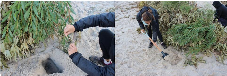
**Figura 11.** Etapa 5 en la instalación de cercas captoras de arena: atado de hilo sisal a los anclajes y enterramiento de los mismos.
