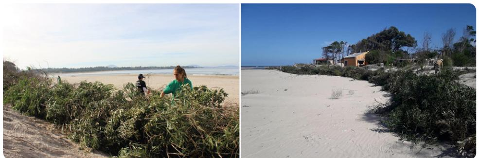
**Figura 8.** Etapa 3 en la instalación de cercas captoras de arena: colocación del material al pie de la duna primaria.
