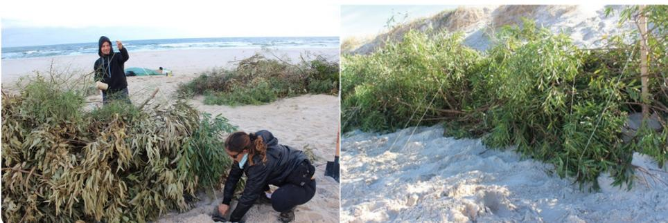
**Figura 12.** Etapa 6 en la instalación de cercas captoras de arena: trenzado con hilo sisal en zig-zag.
