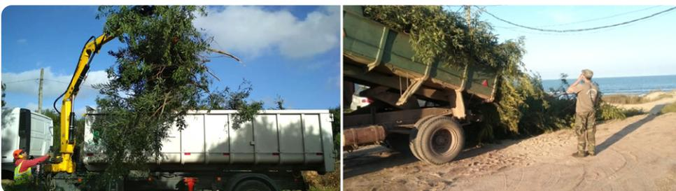
**Figura 6.** Etapa 1 en la instalación de cercas captoras de arena: obtención y traslado de podas.
