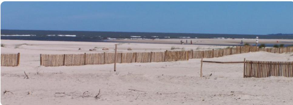
**Figura 5.** Ejemplo de cercas captoras de arena con tablestacado.
