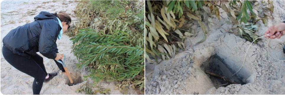
**Figura 10.** Etapa 4 en la instalación de cercas captoras de arena: realización de pozos para anclajes.
