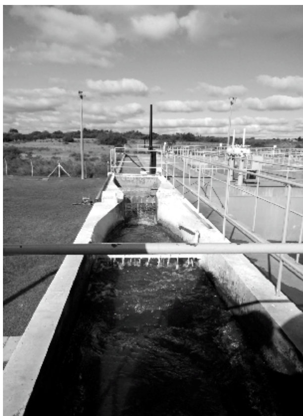
Fotografía: Usina potabilizadora de OSE. Fuente: DINAGUA, 2015
