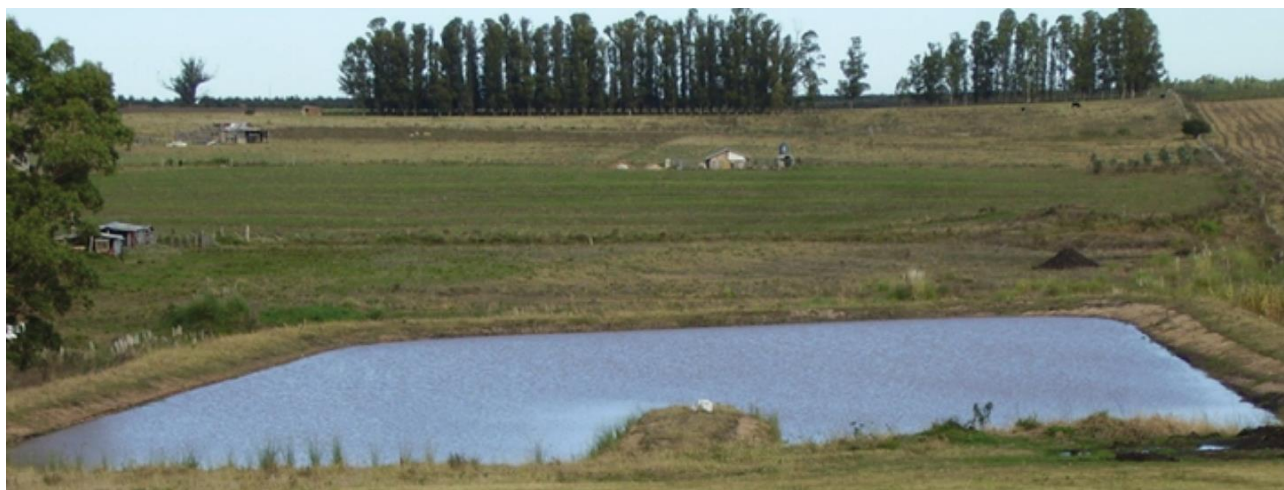
Figura 8.31. Tanque excavado – Fotografía DINAGUA
