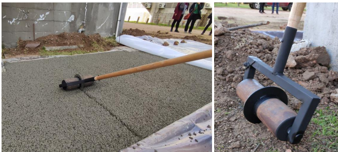
Figura 28. Rodillo “corta-pizza” para realización de juntas.
