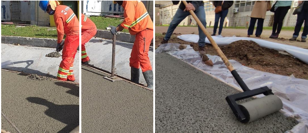
Figura 27. Ejemplo de reparación y compactación local mediante pisón y rodillo manual.
