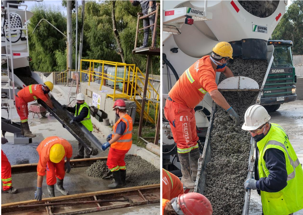
Figura 21. Descarga de hormigón permeable desde mixer.
