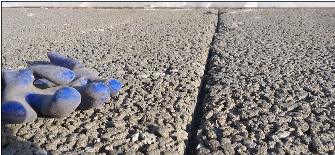
Figura 14. Superficie terminada de hormigón permeable.
