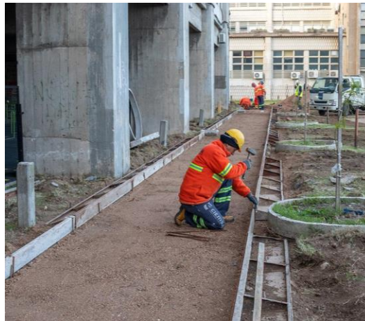
Figura 20. Preparación del terreno previo a la colocación del hormigón permeable.
