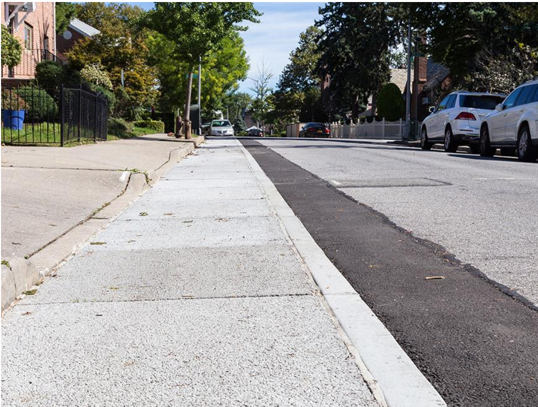
Figura 7. Utilización de hormigón permeable a los laterales de una calle en Rego Park, Queens, Nueva York, Estados Unidos. (Imagen extraída de www.nycstreetdesign.info / Sin copyright)
