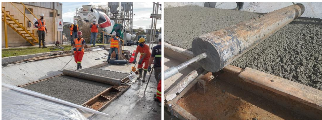
Figura 26. Ejemplo de compactación mediante “rodillo pesado” e imagen del rodillo.
