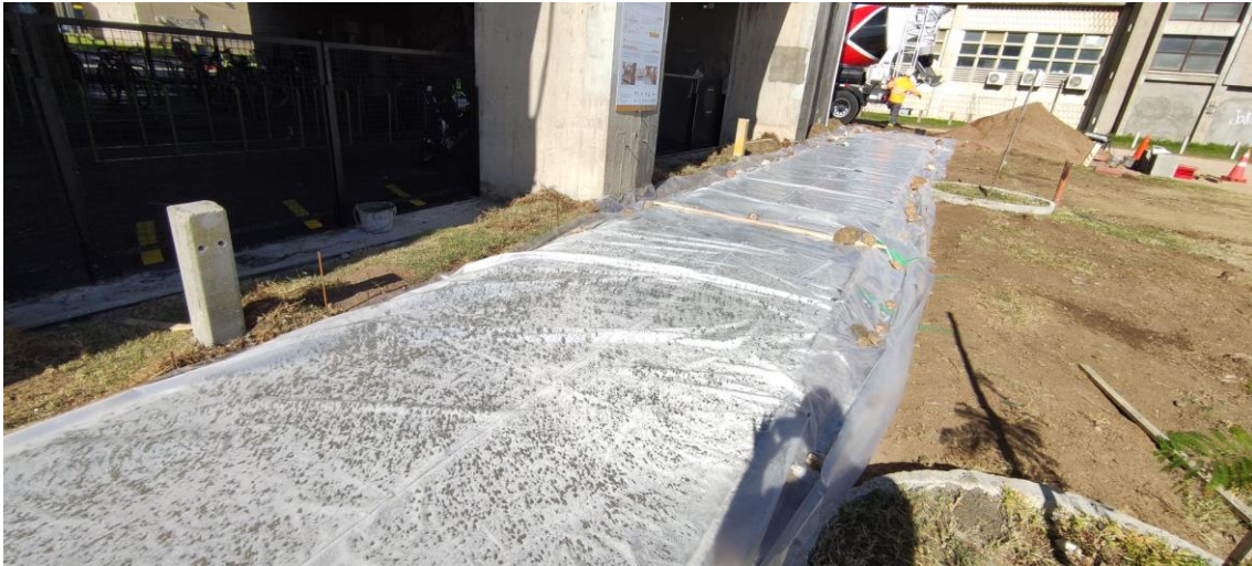
Figura 30. Curado de hormigón permeable utilizando lámina plástica.
