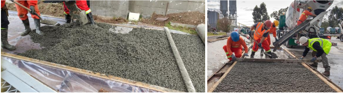
Figura 24. Ejemplo de colocación y nivelación con regla manual.
