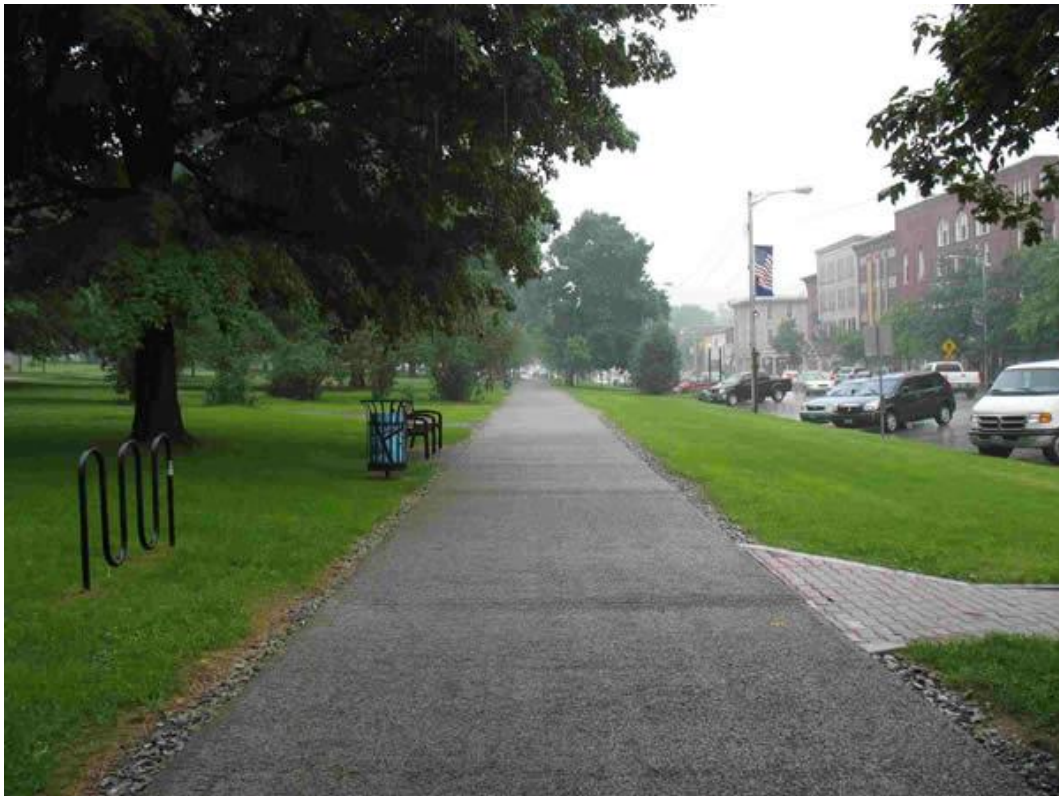
Figura 4. Senda peatonal de hormigón permeable en St. Albans, Vermont, Estados Unidos. (Imagen extraída de www.epa.gov / Sin copyright)
