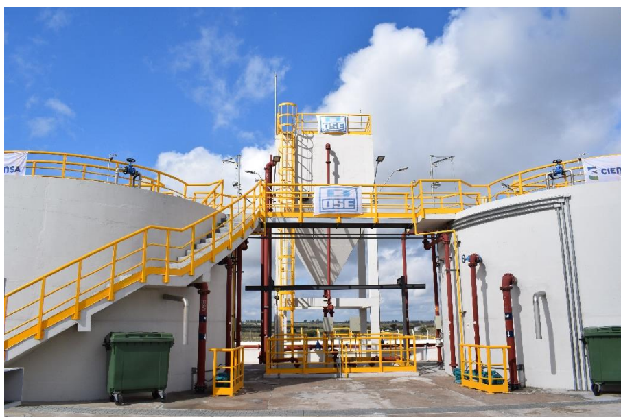
Obra PTAR Fray Marcos
