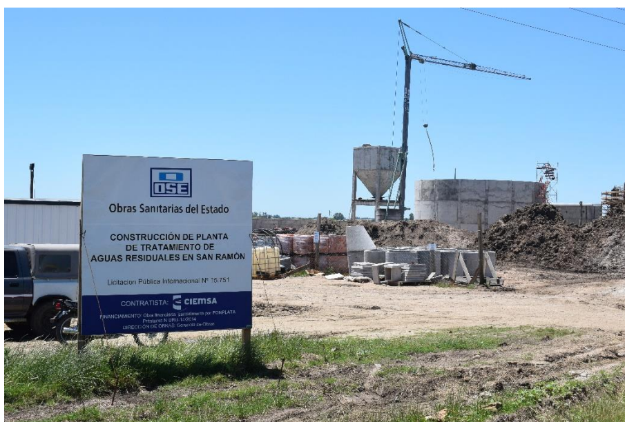
Obra PTAR San Ramón
