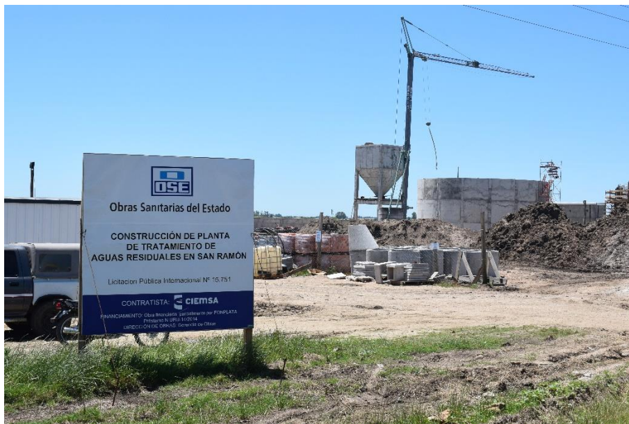
Obra PTAR San Ramón
