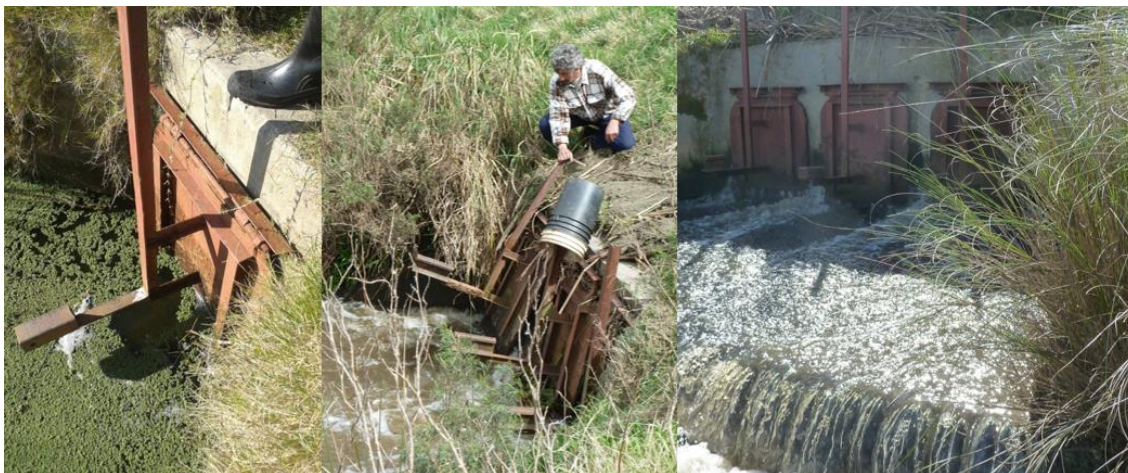
Dique de protección civil en Delta del Tigre - Ciudad del plata
