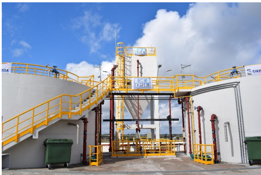
Obra PTAR Fray Marcos
