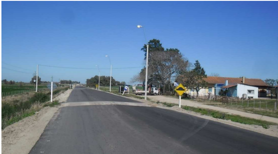
Lomos de burro en escuelas con iluminación vial
