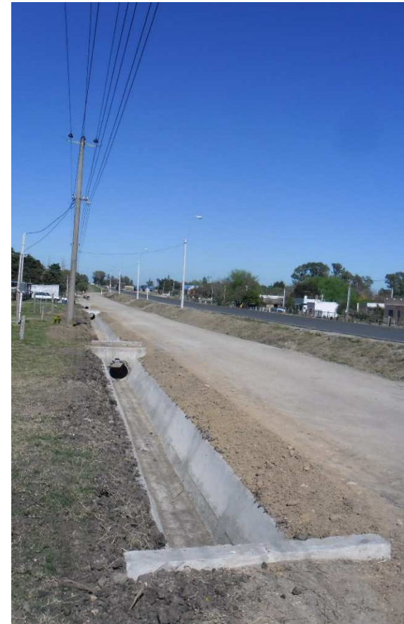
Nueva calle de servicio con cuneta revestida en hormigón
