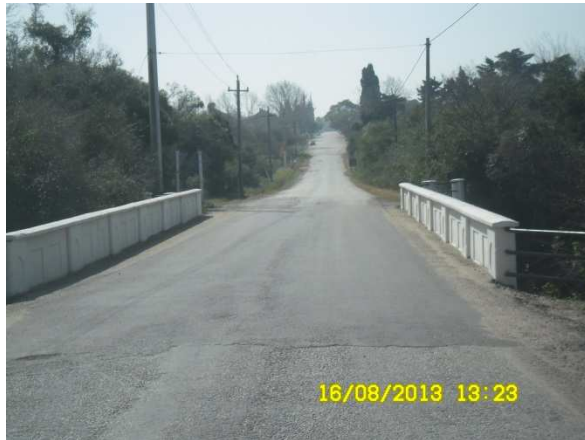
Calzada en concreto asfáltico en puente
