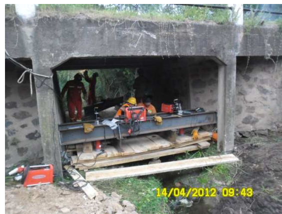
Se hizo el refuerzo estructural del puente
