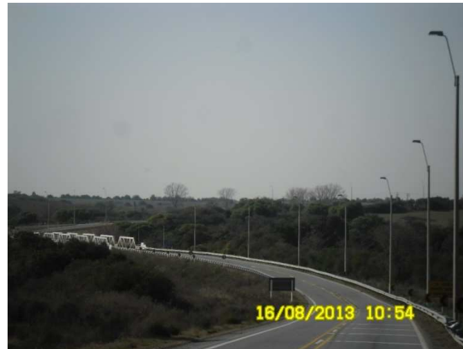
Puente paso El Pelado
