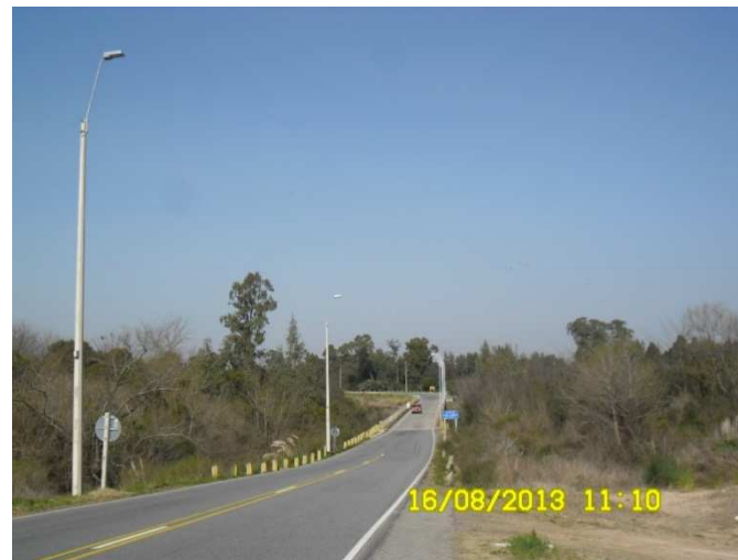
Puente paso La Horqueta
