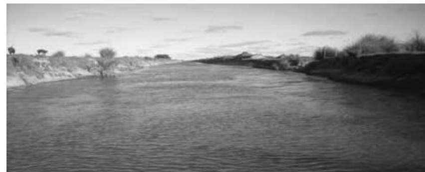
Tramo del Canal N°1 | Fotografía: DINAGUA
