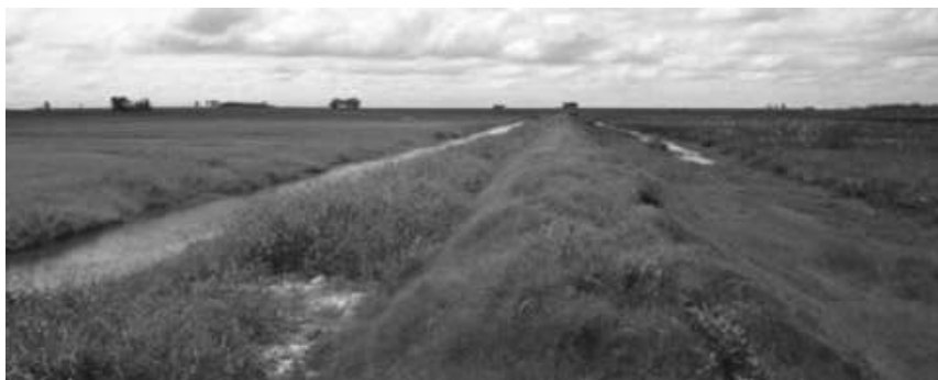
Terraplén | Fotografía: DINAGUA
