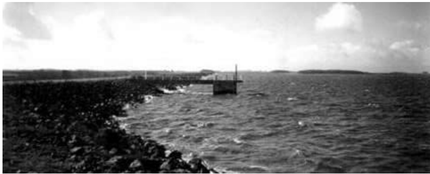
Represa del arroyo India Muerta | Fotografía: DINAGUA
