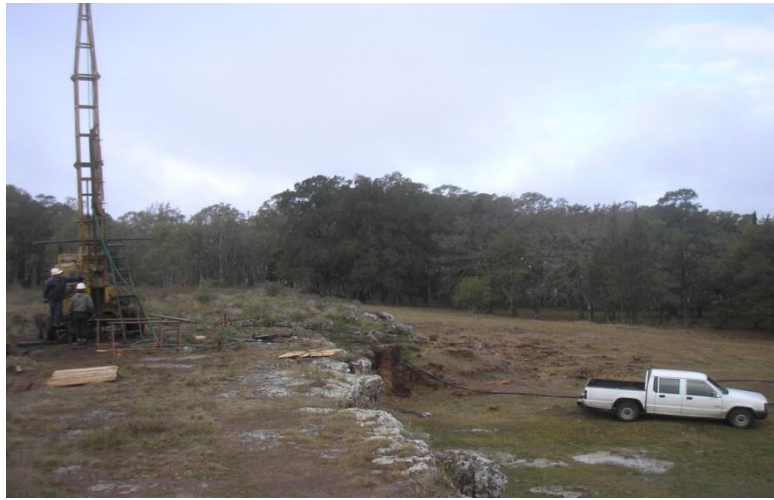
Figura 9. Detalle de la torre de perforación
