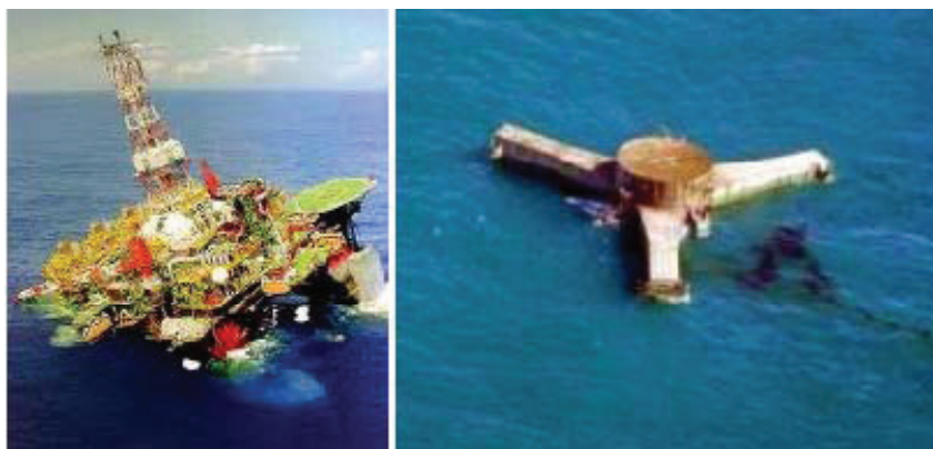
Figura 12. Imágenes del accidente de la plataforma P-36 y de la falla de la mini-TLP Typhoon.
