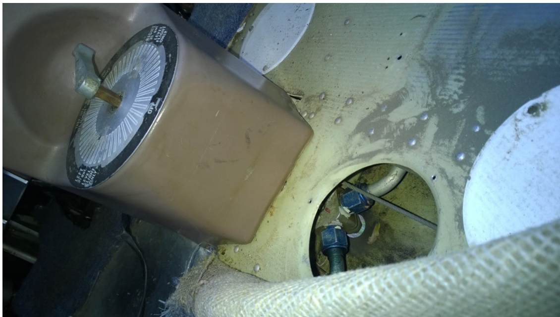
Foto 1. Vista de la selectora de combustible
