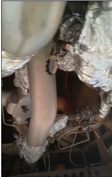
Imagen 11. Puede verse papel de aluminio recubriendo las diferentes uniones en la pack en el proceso de búsqueda de pérdidas.
