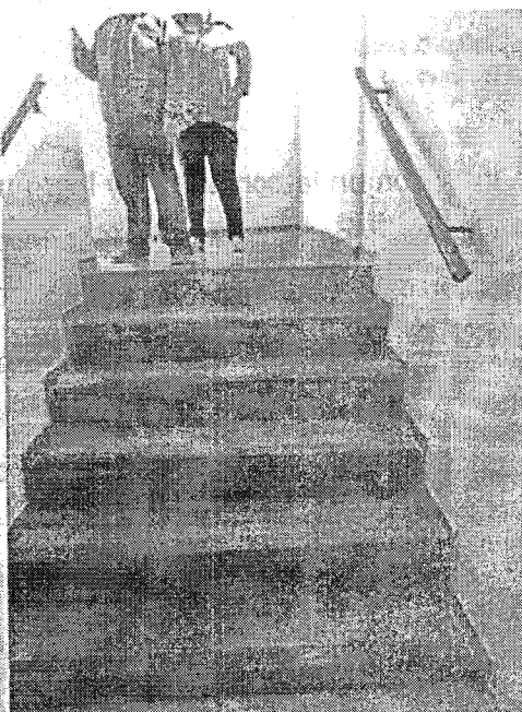
Foto 4: Escalera a la planta alta
