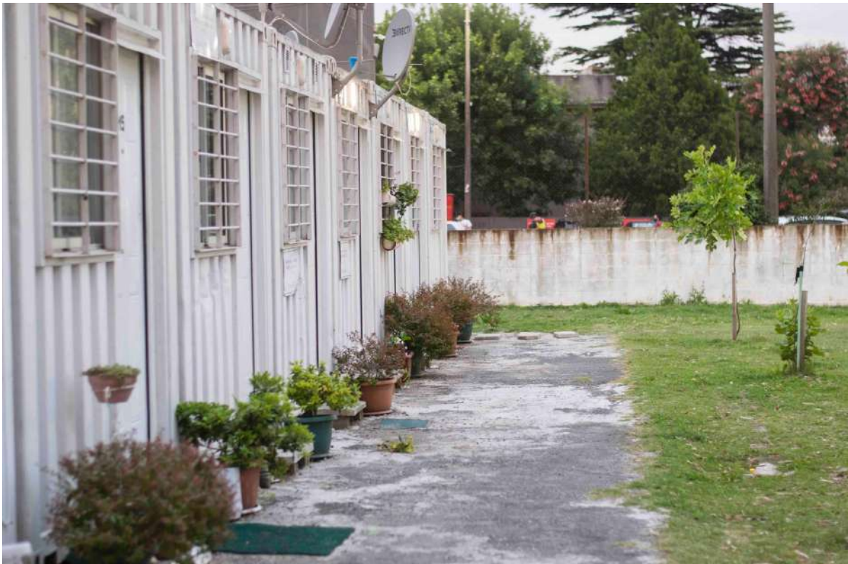
Detalle del frente de habitaciones. Foto: equipo DINTAD.
