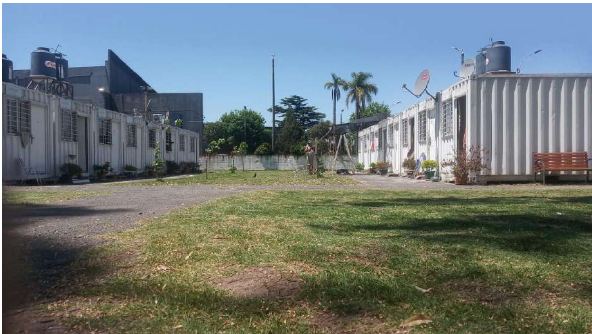
Hileras de módulos en el complejo. Foto: equipo DINTAD.
