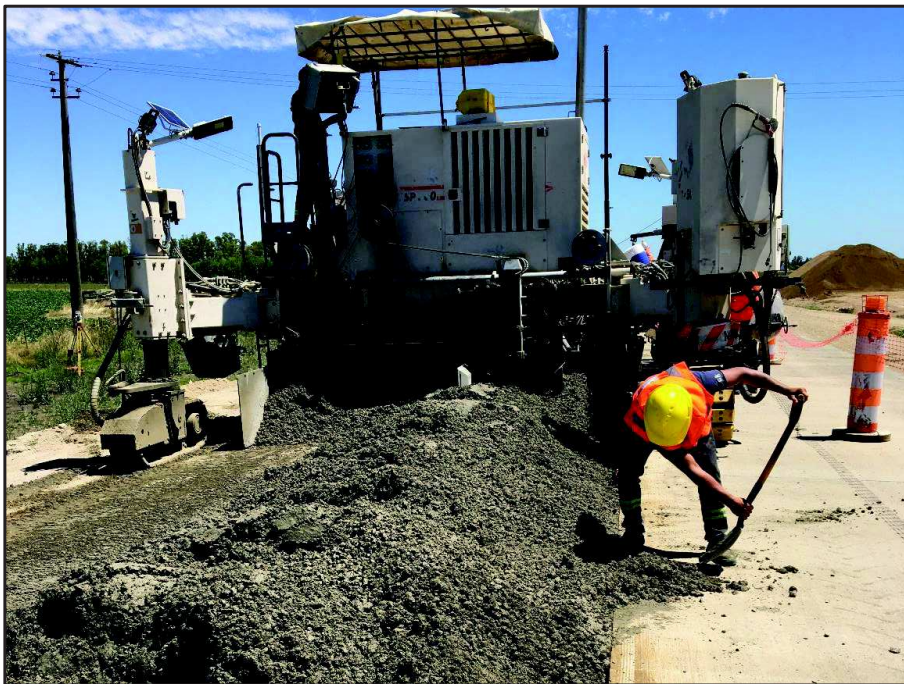
Ilustración 7: Pavimentación, Tramo 493, Ruta 55
