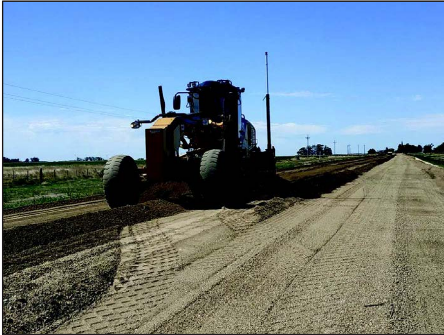
Ilustración 12: Refinado de base de tosca, Tramo 492, Ruta 54
