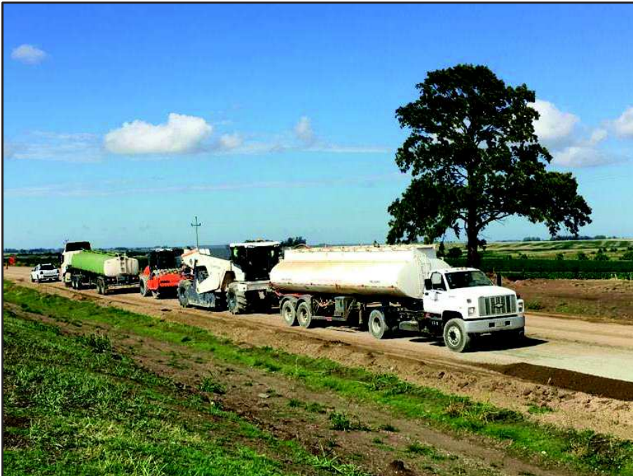
Ilustración 13: Tren de reciclado, Tramo 492, Ruta 54
