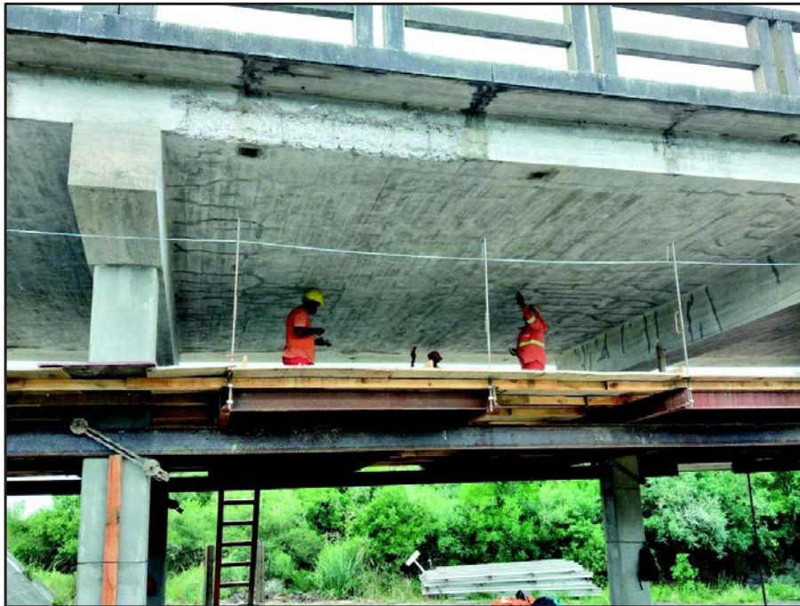
Ilustración 23: Reparación fisuras, Río San Juan, Ruta 54
