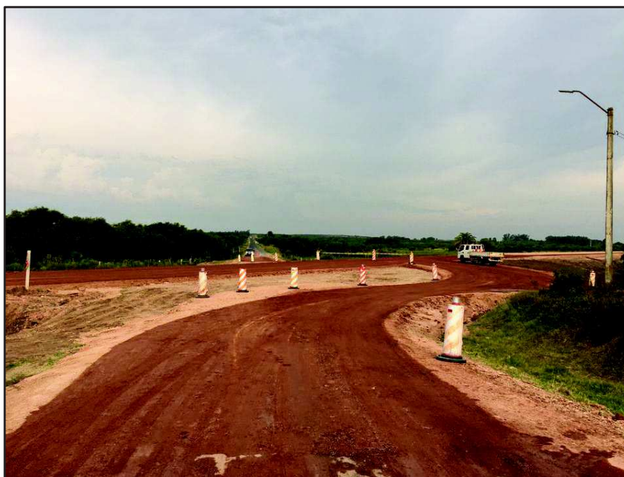
Ilustración 5: Empalme Bypass Carmelo-Cno. Las Tunas
