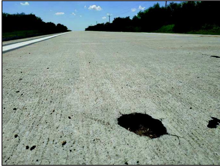
Ilustración 3: Pozo en calzada
