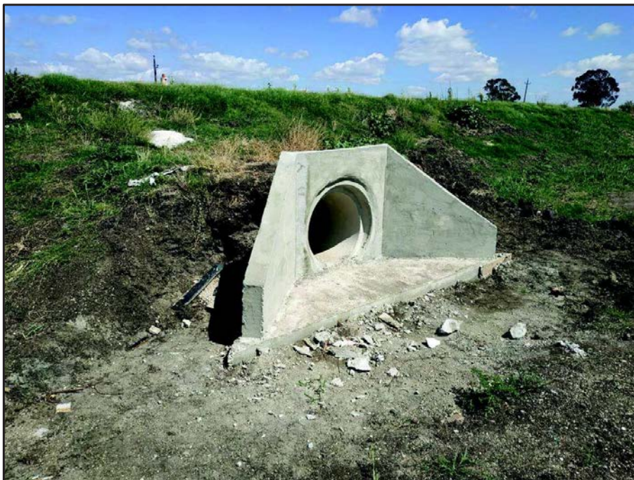
Ilustración 9: Alargue de alcantarilla, Tramo 490-491, Ruta 54 (2)
