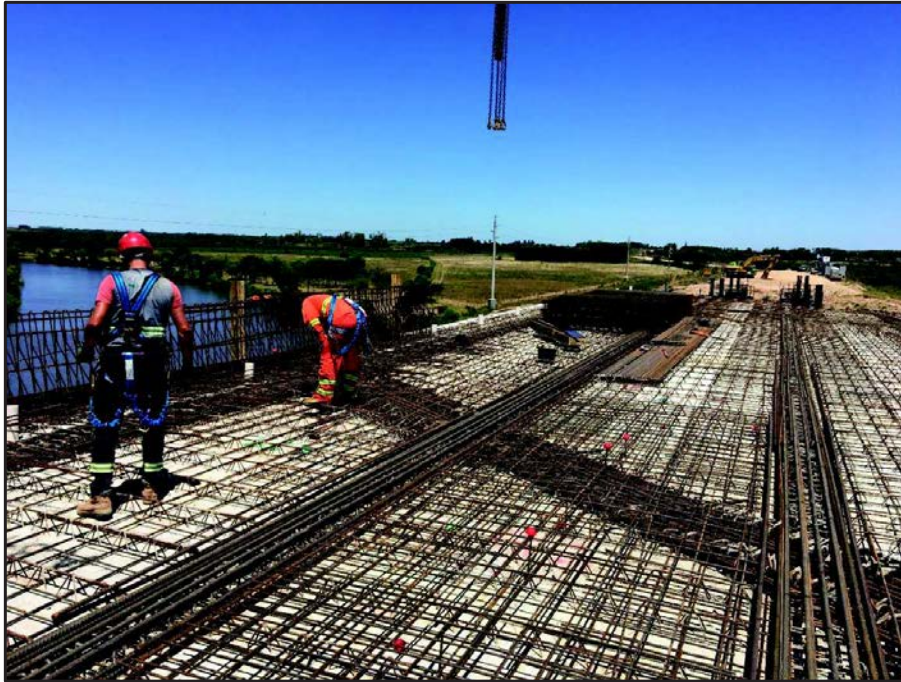
Ilustración 19: Vista sobre el tablero A° Las Vacas
