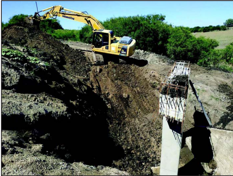
Ilustración 10: Terraplenado sobre puente en Arroyo Sauce Chico
