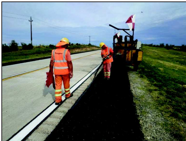
Ilustración 4: Sellado de junta calzada-banquina tramos 3 y 4
