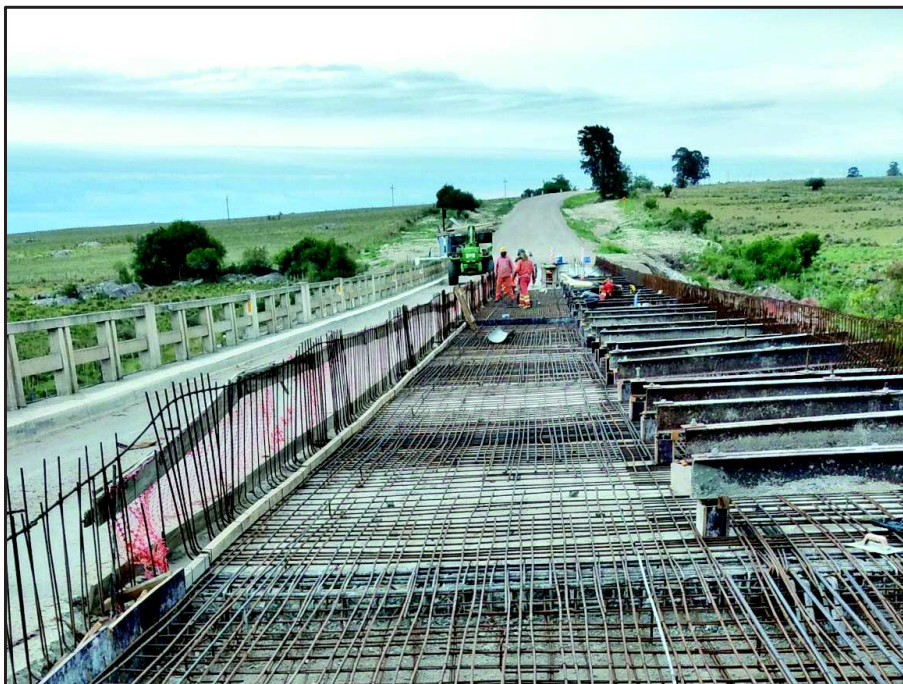
Ilustración 22: Tablero, Río San Juan, Ruta 54
