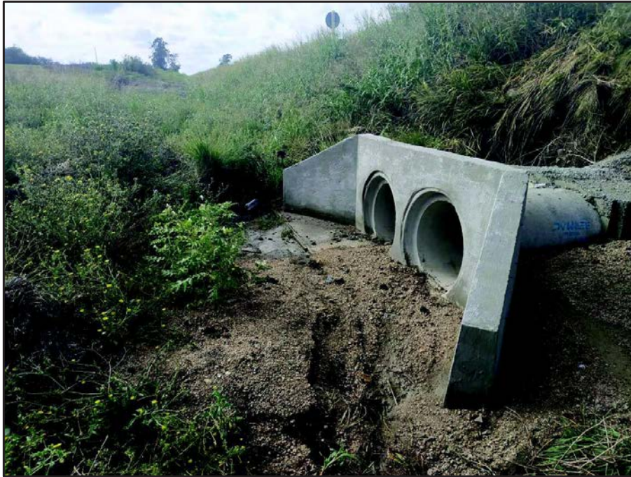
Ilustración 8: Alargue de alcantarilla, Tramo 490-491, Ruta 54
