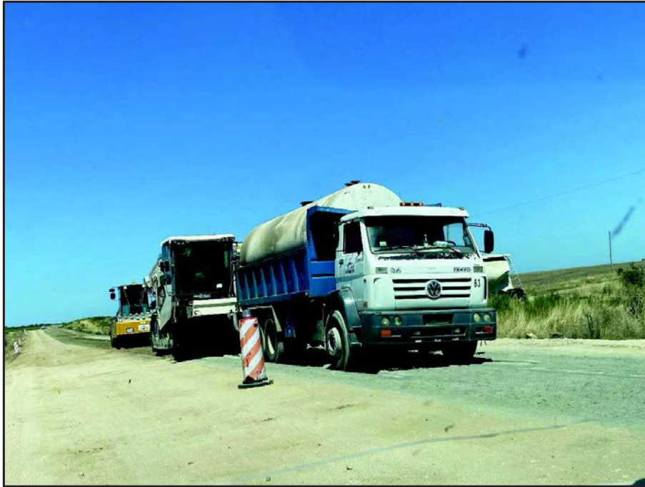
Ilustración 16: Reciclado de bases, Tramo 501 Ruta 57
