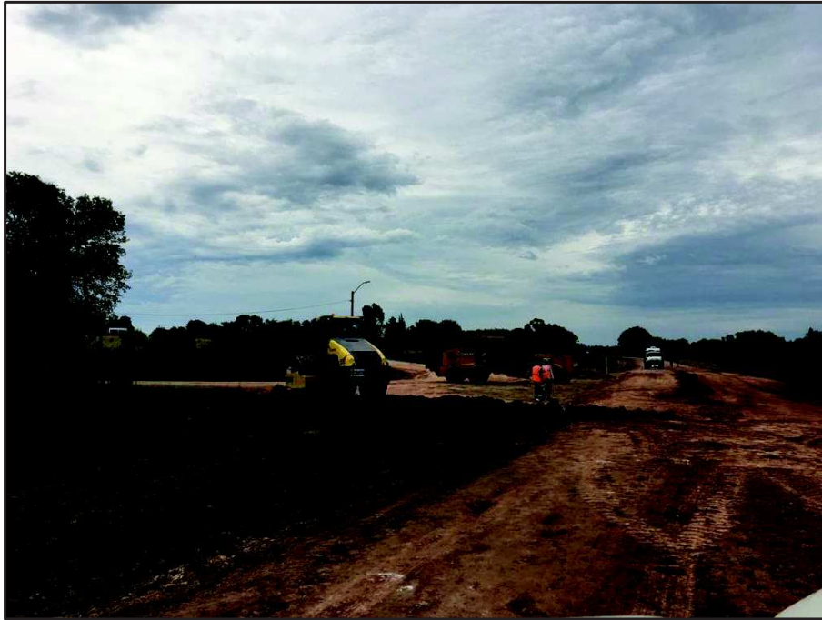
Ilustración 6: Empalme Bypass Carmelo-Cno. Las Tunas (2)
