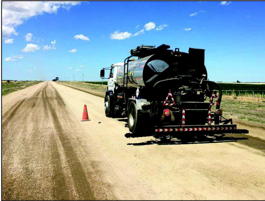
Ilustración 14: Riego de emulsión asfáltica, Tramo 492, Ruta 54
