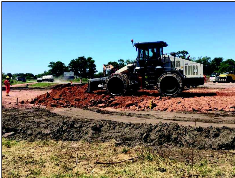
Ilustración 4: Empalme Bypass Carmelo-Ruta 97
