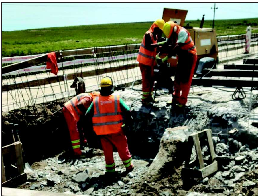
Ilustraciones 26: Preparación losa de acceso, A° Miguelete, Ruta 54
