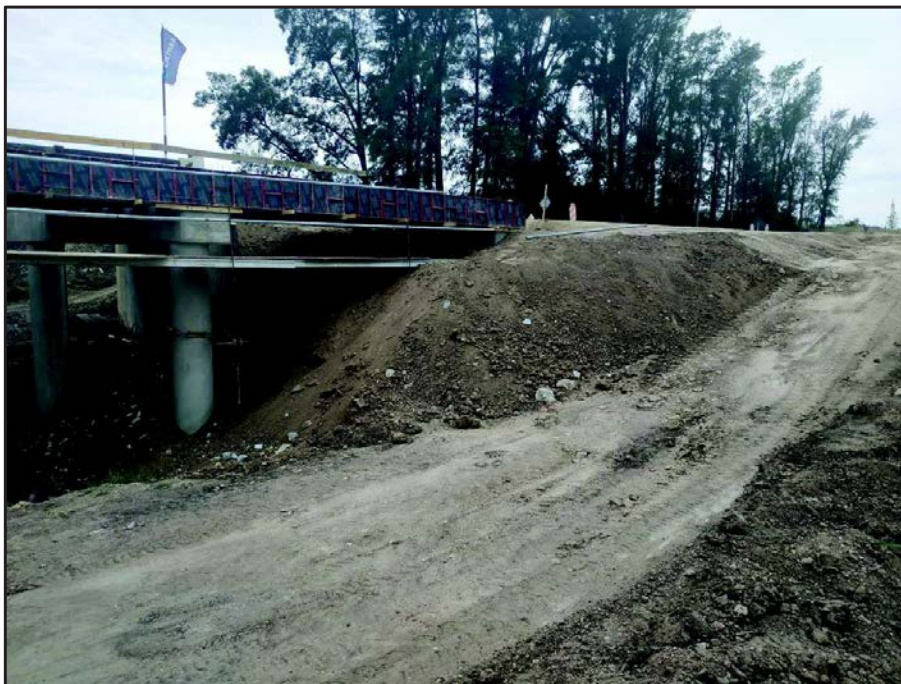
Ilustración 11: Acceso terminado en puente sobre Arroyo Sauce Chico
