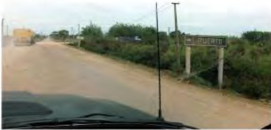
Foto 1: Circunvelación de acceso al puerto de Nueva Palmira. Pavimento de tratamiento bituminoso remanente casi inexistente.
