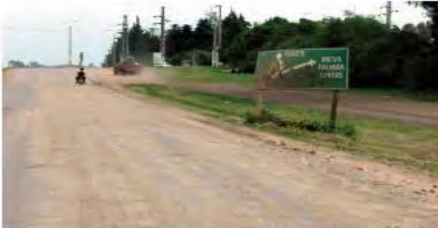
Foto 2: Acceso al puerto con recargo de material granular y bajo un mantenimiento precario.
