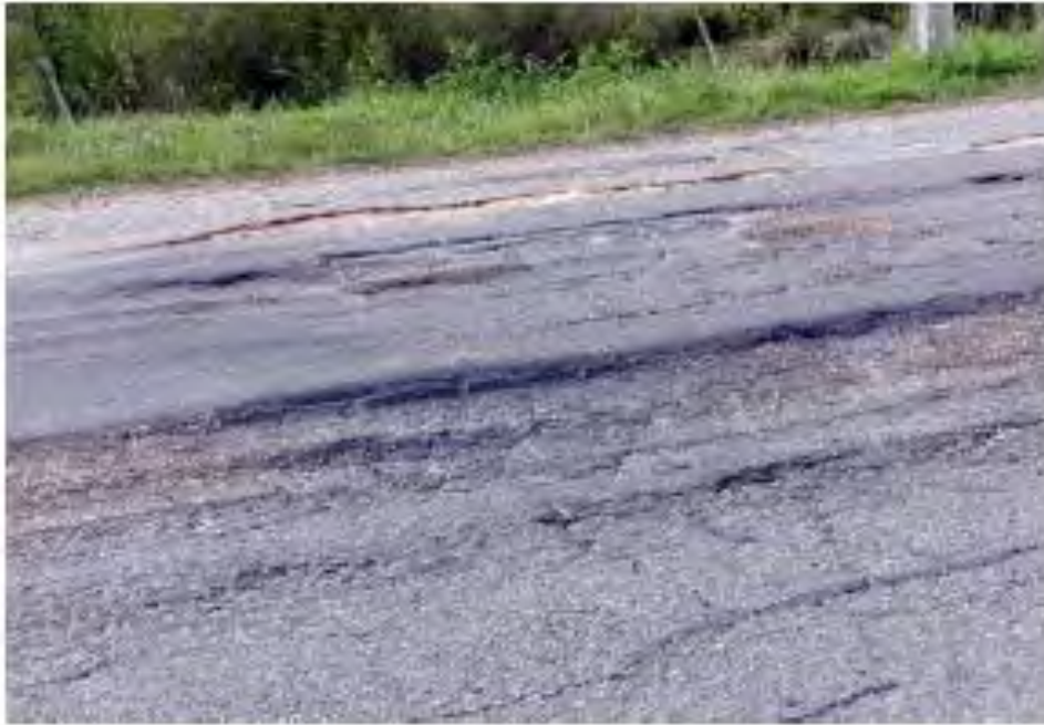
Foto 5: Ruta 24 a km de empalme con Ruta 2, ahuecimientos de magnitud en senda (-) con IRI del tramo 3,11.
