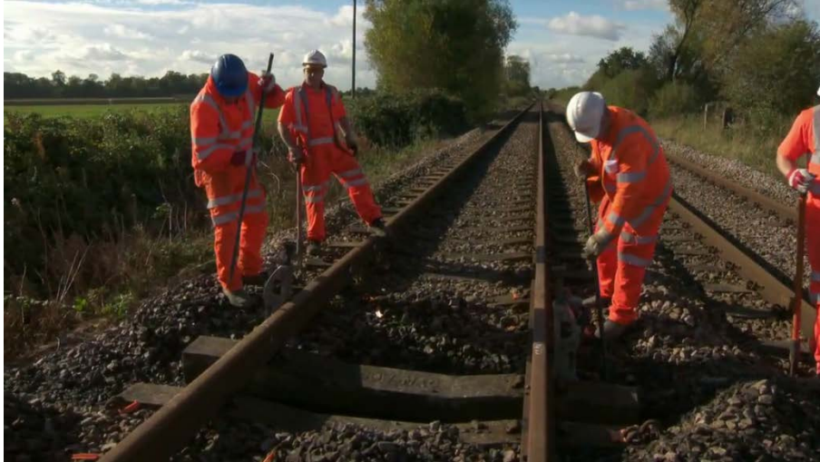
Figura 4.1 Ejemplo de mantenimiento manual. Recambio de un durmiente de hormigón
