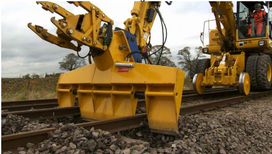
Figura 4.2 Ejemplo de mantenimiento mecanizado. Recambio de un durmiente de hormigón.
