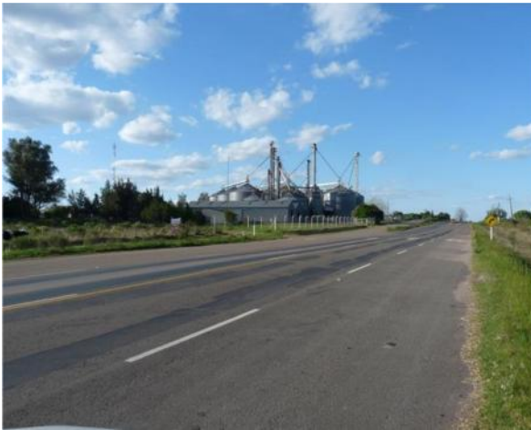
Instalación industrial en Agraciada. Ruta 12
