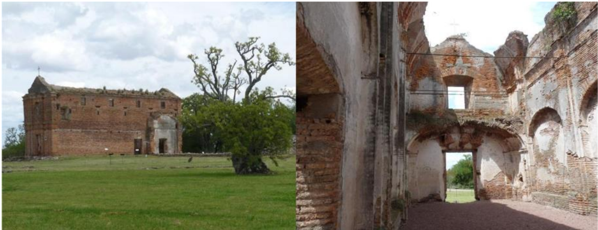
Fotografía 4 Calera de las Huérfanas
