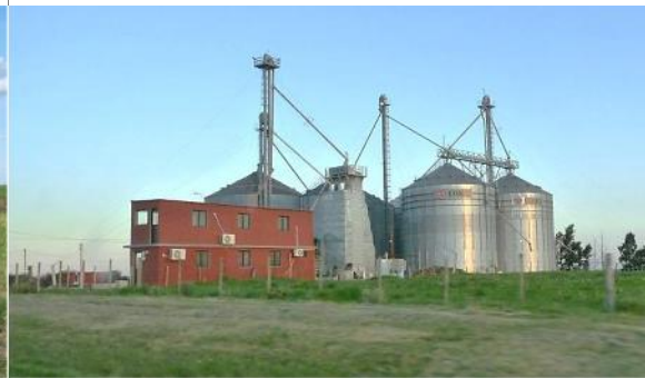
Instalaciones de almacenamiento habituales
