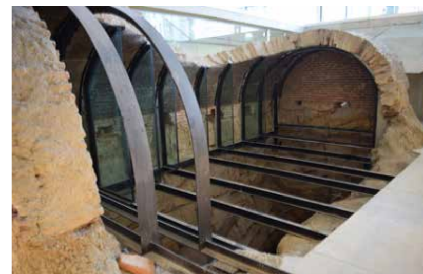
Consolidación estructural finalizada, 2018
