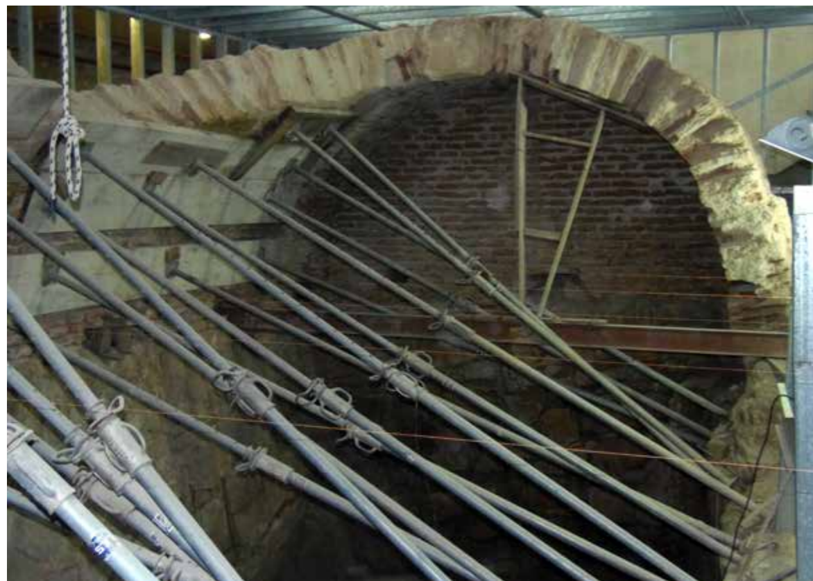
Proceso de la consolidación estructural, 2017
