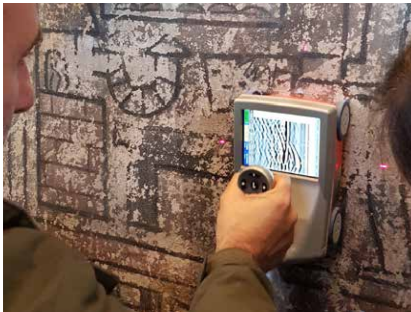
Estudio de termografía infrarroja y radar penetrante realizado por el Ing. Gonzalo Cetrangolo del Departamento de Estructuras de la Facultad de Ingeniería - UdelaR
