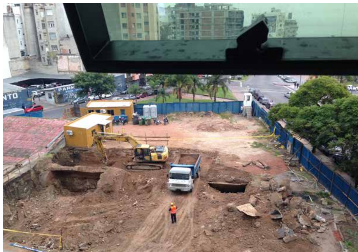
El hallazgo y el contexto de obra vistos desde el edificio de Presidencia, 2014
