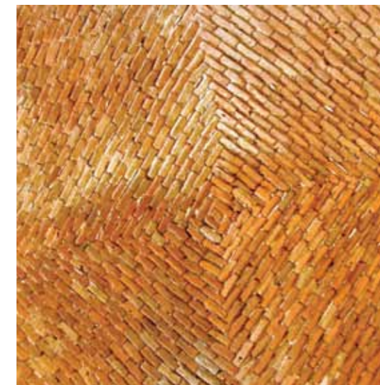
Cubierta de Las Bóvedas.
