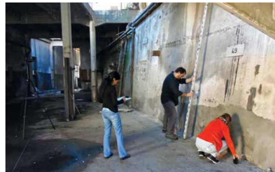
Relevamiento de tramo de contraescarpa del Baluarte de San Luis.
