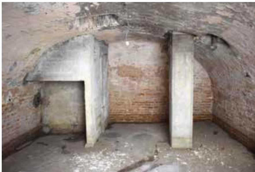
Fig. 72. Cisterna que presenta intervenciones posteriores que evidencian usos diferentes al original. Ubicada en calle Colón esquina Washington, Ciudad Vieja. Caso n.º 19
