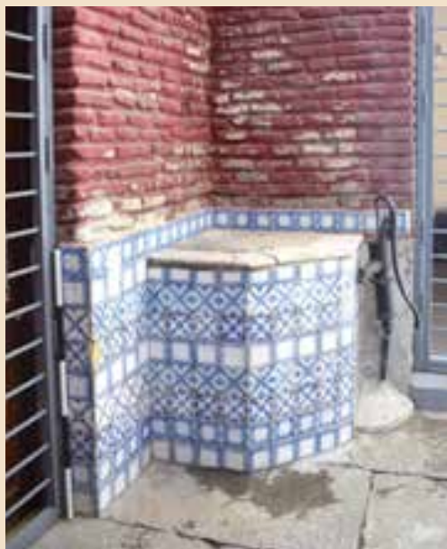
Fig. 47. Brocal facetado revestido con azulejos Pas de Calais situado en el patio abierto de un inmueble ubicado en la calle Rambla 25 de Agosto, Ciudad Vieja. Actualmente sellado. Caso n.º 28
