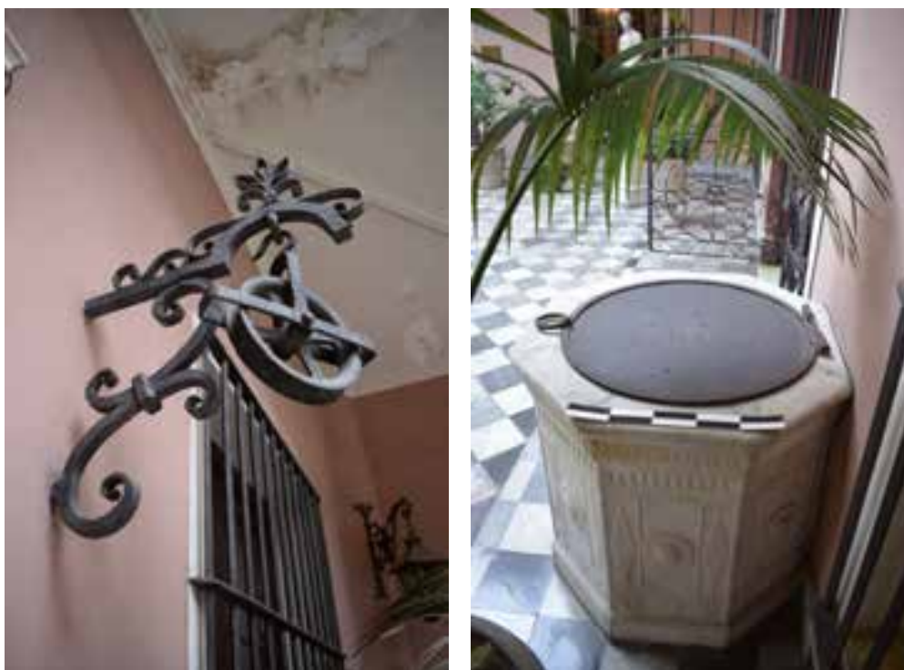
Fig. 52. Pescante con polea y brocal de mármol facetado de ocho lados con tapa de hierro. Casa de Antonio Montero, actual Museo Romántico, Ciudad Vieja
