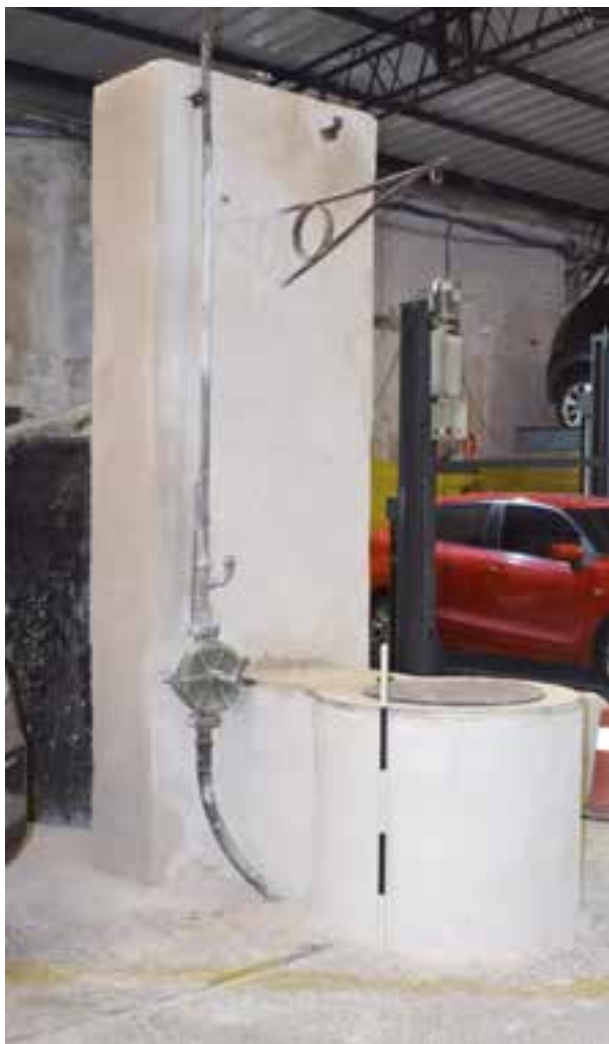
Fig. 60. Brocal cilíndrico de un aljibe con soporte de hierro para colocar la garrucha, ubicado en la calle 25 de Mayo, Ciudad Vieja. Caso n.º 5
