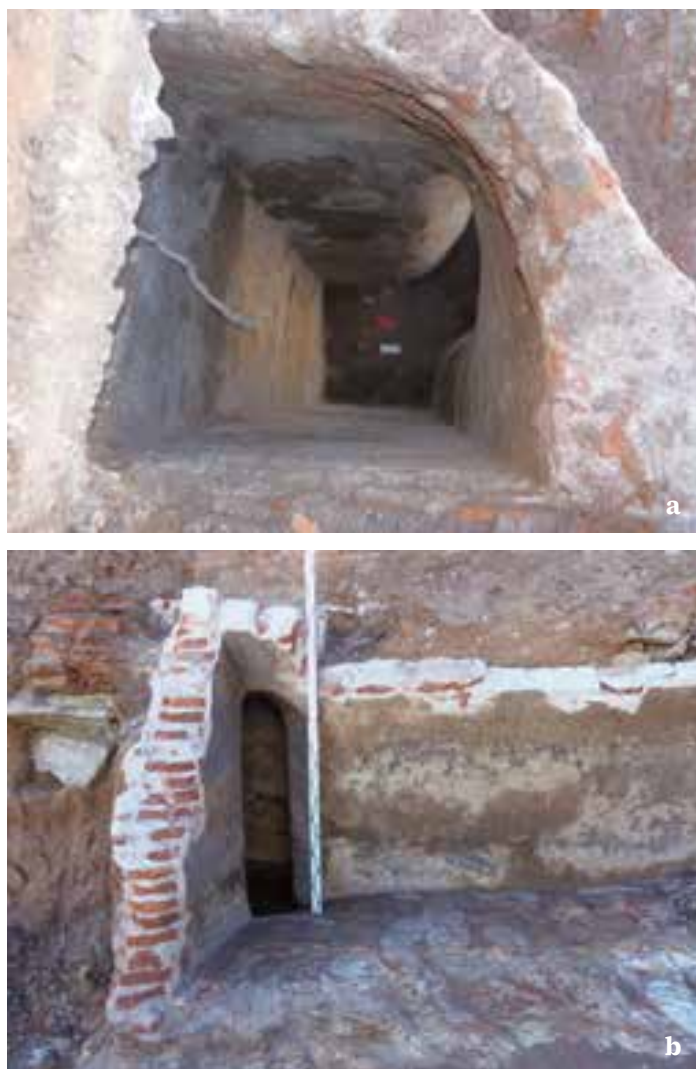
Fig. 69a. Vista cenital del pozo de decantación, tomada desde el brocal. 69b. Vista frontal de la abertura de conexión entre la cisterna y el ducto del brocal. Reconquista, esquina Zabala, Ciudad Vieja. Caso n.º 8
