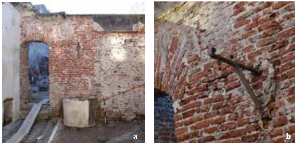
Fig. 55a. Brocal cilíndrico de un aljibe emplazado en el patio de una vivienda del siglo XIX. 55b. Detalle del pescante que sostenía la polea. Calle Reconquista, Ciudad Vieja. Caso n.º 22
