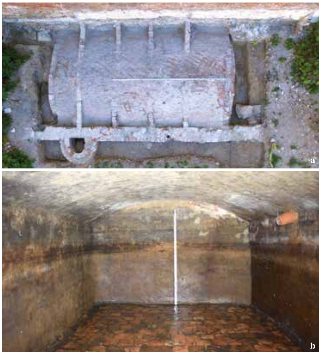
Fig. 18. Cisterna de aljibe registrada durante excavación arqueológica en calle Piedras, Ciudad Vieja. 18a. Vista cenital de la cisterna con parte de su brocal. Se observa la cubierta abovedada. 18b. Vista del interior de la cisterna. Caso n.º 20
