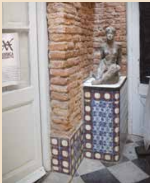
Fig. 48. Brocal revestido con azulejos Pas de Calais, integrado a un taller de arte, calle Washington, Ciudad Vieja. Caso n.º 27
