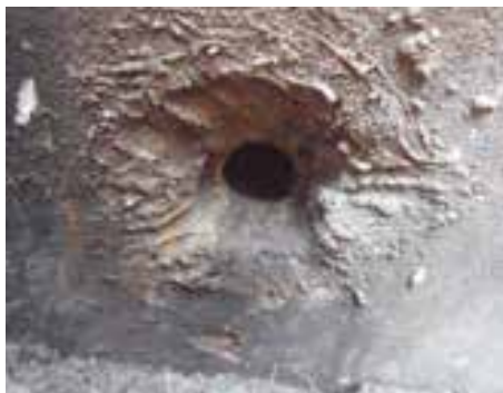
Fig. 40. Punto de desagüe de una canalización de cerámica en la cisterna excavada en la calle Agraciada, Capurro-Bella Vista. Caso n.º 12
