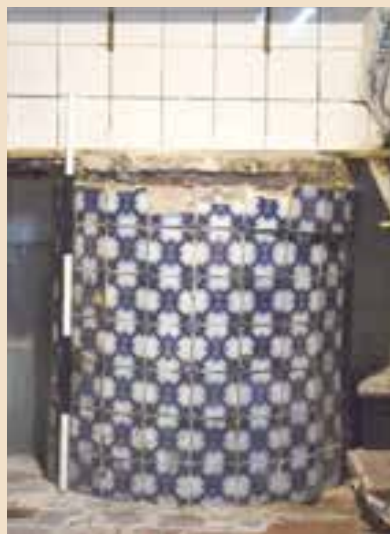
Fig. 49. Brocal sellado, relicto de un aljibe. Forma cilíndrica, revestido con azulejos Pas de Calais. Ubicado en un inmueble de la calle Misiones. Ciudad Vieja. Caso n.º 25
