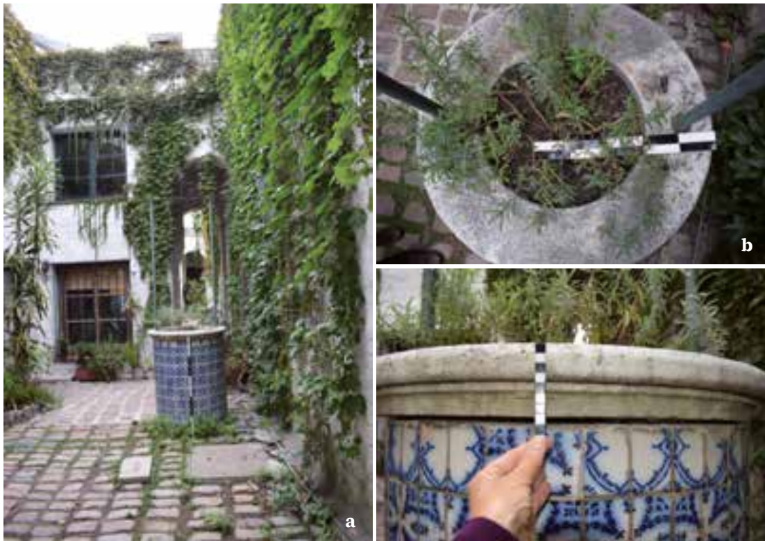
Fig. 46. Brocal ubicado en un patio de un inmueble ubicado en Ciudad Vieja. 46a. Brocal cilíndrico, revestido con azulejos Pas de Calais situado en el patio abierto de un inmueble de la calle Maciel, Ciudad Vieja. Actualmente cumple un uso ornamental como macetero. 46b y 46c. Pieza de mármol que remata el brocal. Caso n.º 26
