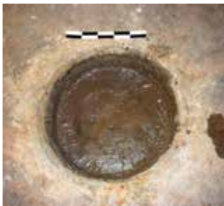
Fig. 77. Se observa el pozo de decantación de forma circular, revocado. Aljibe ubicado en la calle Reconquista, Ciudad Vieja. Caso n.º 22
