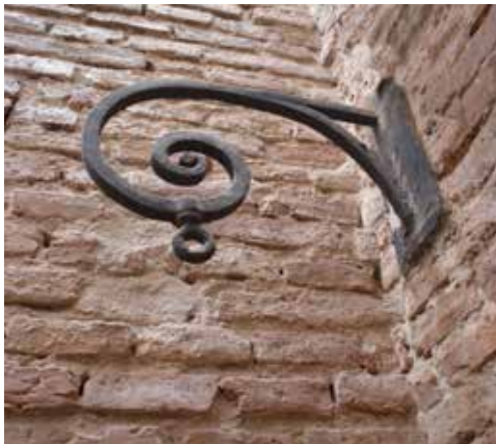
Fig. 54. Soporte de hierro forjado encima del brocal. Calle Washington, Ciudad Vieja. Caso n.º 27
