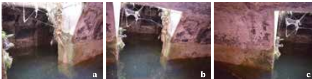
Figs. 67 a, b y c. Cisterna de aljibe con dos cámaras comunicadas, ubicada en el segundo patio de una casa colonial, Solar de Burgues, calle Ituzaingó, Ciudad Vieja. Caso n.º 23
