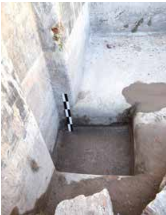
Fig. 79. Pozo de decantación de forma cuadrada. Aljibe ubicado en la calle Ituzaingó, Ciudad Vieja. Caso n.º 14
