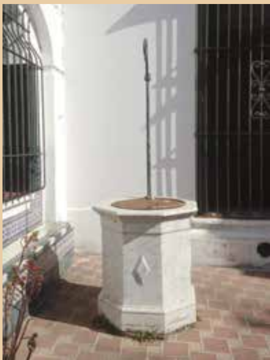
Fig. 50. Aljibe con brocal de mármol de una sola pieza, en la Quinta de Taranco, ubicada en la zona rural de Melilla
