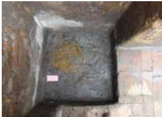
Fig. 78. Pozo de decantación de forma rectangular, revocado. Aljibe ubicado en la calle Reconquista, Ciudad Vieja. Caso n.º 7
