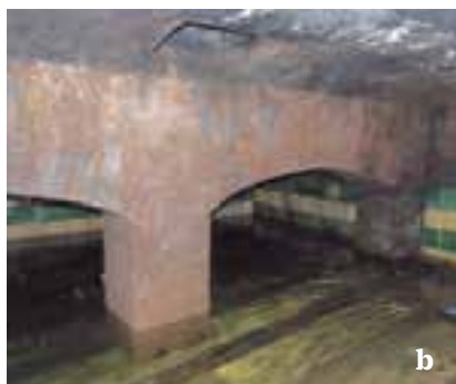
Figs. 66 a y b. Cisterna de dos cámaras unidas a través de arcadas, cada una de planta rectangular y cubierta abovedada. Llama la atención el revestimiento del pavimento y de la parte inferior de las paredes con baldosas cerámicas esmaltadas, colocadas según el color formando patrones. Esta construcción, por su capacidad, diseño y materiales, corresponde a una vivienda lujosa de mediados del siglo XIX. Calle 25 de Mayo, Ciudad Vieja. Caso n.º 5
