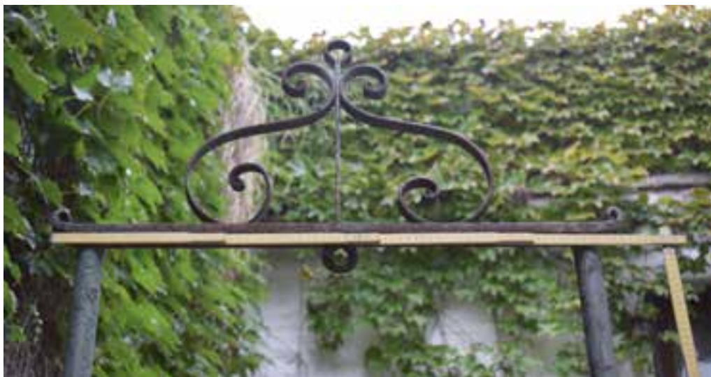
Fig. 56. Soporte de hierro forjado encima del brocal. Calle Maciel, Ciudad Vieja. Caso n.º 26
