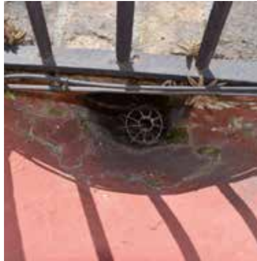
Fig. 38. Otro tipo de rejilla (contemporánea) colocada en el desagüe de la azotea, en Solar de Burgues, calle Ituzaingó, Ciudad Vieja. Caso n.º 23
