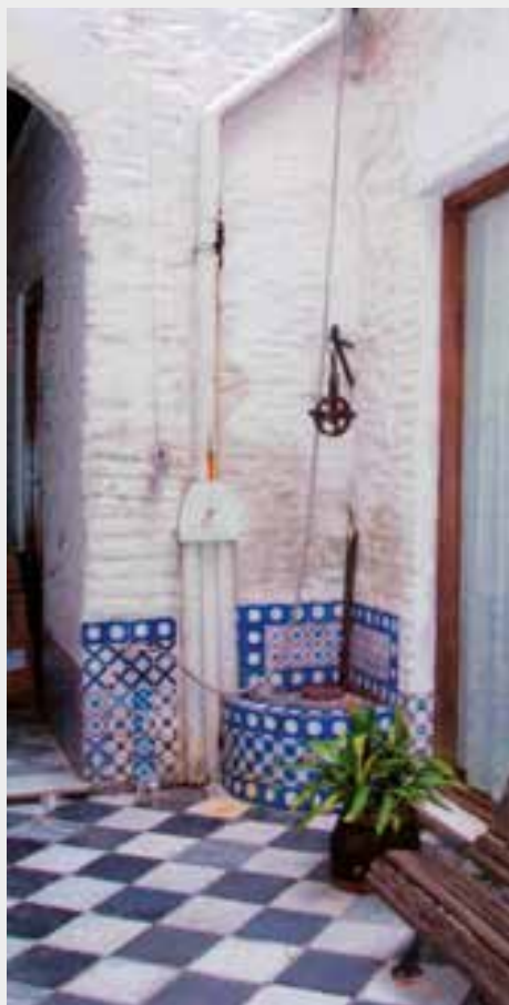
Fig. 80. En la pared a la izquierda del brocal se observa el dispositivo que permite dividir las aguas pluviales hacia la cisterna o hacia el saneamiento. En Inventario del Patrimonio Arquitectónico y Urbanístico de Ciudad Vieja, IM.
