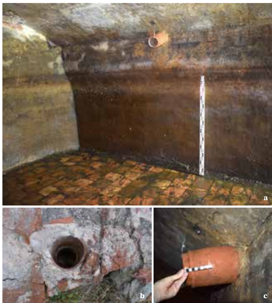
Fig. 35. Canalización en cerámica que vierte agua en la cisterna. 35a. Interior de la cisterna con la ubicación del punto de desagüe. 35b. Vista exterior de la canalización empotrada en el muro de la cisterna. 35c. Detalle del punto de desagüe en la cisterna (vista interior). Calle Piedras, Ciudad Vieja. Caso n.º 20
