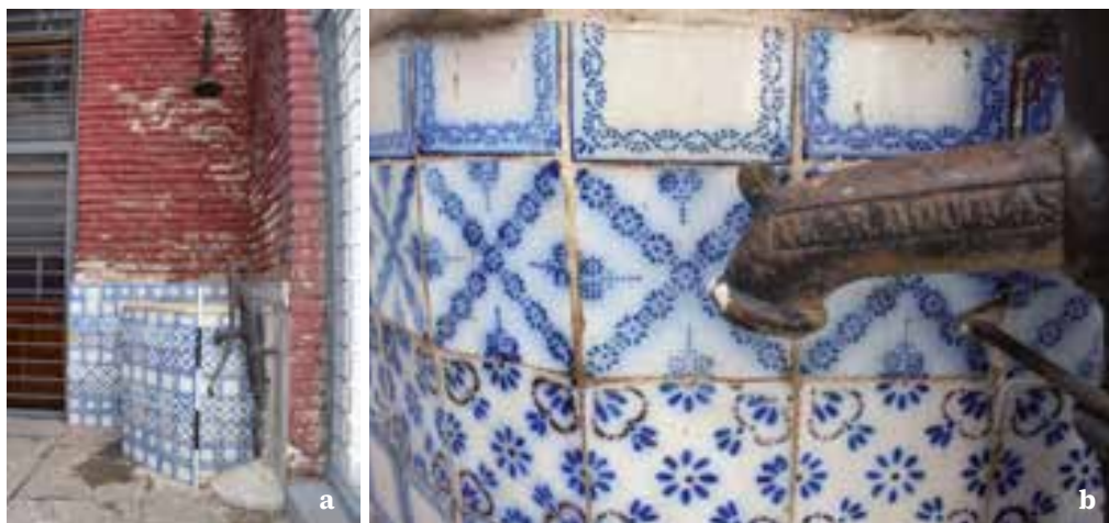
Fig. 41. Brocal de aljibe ubicado en un patio abierto de un inmueble de Ciudad Vieja. 41a. Vista de un brocal de aljibe. Se observa asimismo la bomba de agua ubicada en un lateral. 41b. Vista en detalle de la bomba de agua. Se observa la inscripción «W.&R.DOUGLAS». Relevamiento arqueológico en calle Rambla 25 de Agosto, Ciudad Vieja. Caso n.º 28
