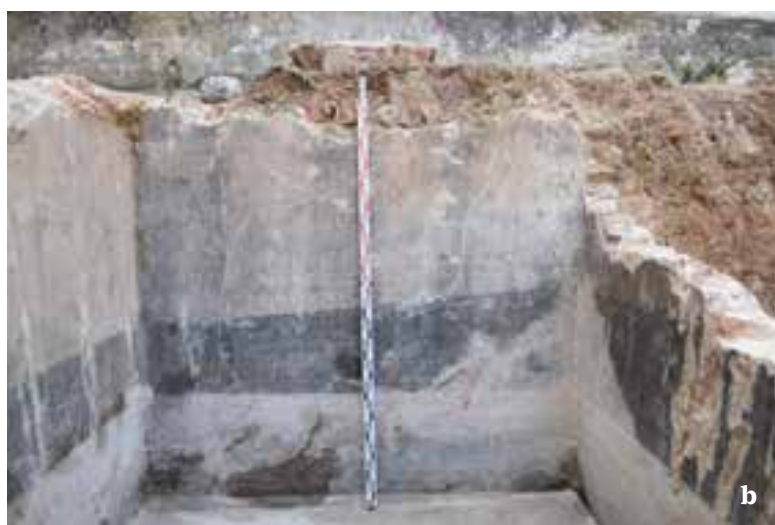
Figs. 86 a y b. Cisterna de un aljibe construido a inicios del siglo XX. Se observa el empleo de cemento portland en el revoque y alisado de las paredes. Calle Ituzaingó, Ciudad Vieja. Caso n.º 14
