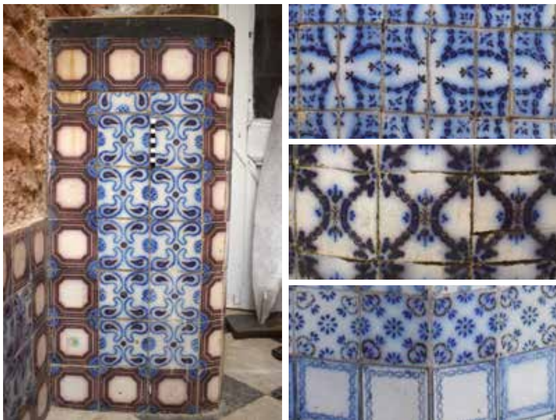
Fig. 45. Diferentes tipos de azulejos Pas de Calais registrados en los brocales relevados. Casos n.º 25, 26, 27 y 28
