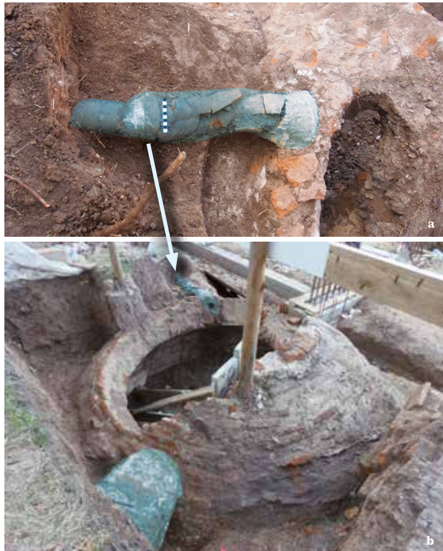
Fig. 34a. Detalle de una de las canalizaciones que vierten agua en la cisterna, conformada por una cañería cerámica de sección circular. 34b. Se observan dos tipos de canalizaciones que vierten agua en la misma cisterna: una cañería cerámica de sección circular; otra cañería de ladrillos de sección rectangular. Calle Agraciada, Capurro-Bella Vista. Caso n.º 12
