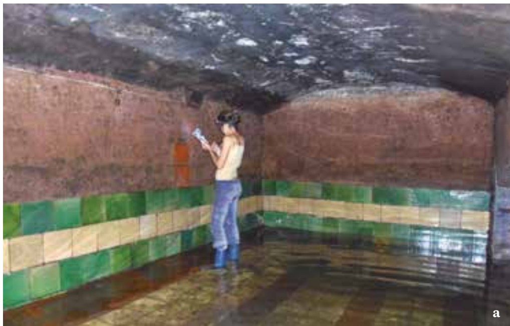
Figs. 66 a y b. Cisterna de dos cámaras unidas a través de arcadas, cada una de planta rectangular y cubierta abovedada. Llama la atención el revestimiento del pavimento y de la parte inferior de las paredes con baldosas cerámicas esmaltadas, colocadas según el color formando patrones. Esta construcción, por su capacidad, diseño y materiales, corresponde a una vivienda lujosa de mediados del siglo XIX. Calle 25 de Mayo, Ciudad Vieja. Caso n.º 5
