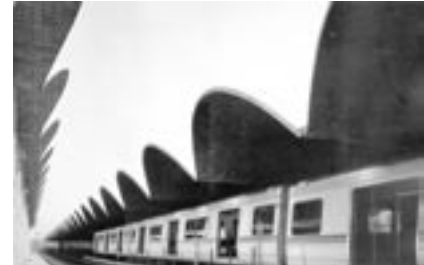
Hangares del metro de Rio de Janeiro. Brasil [1979].
