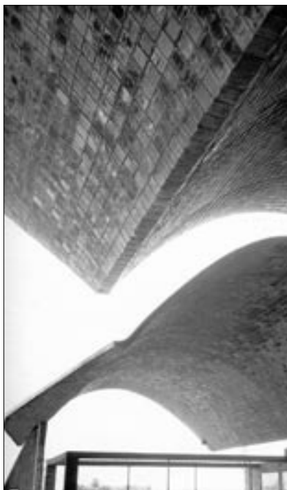
Bóvedas autoportantes en Domingo Massaro SA, Canelones.
