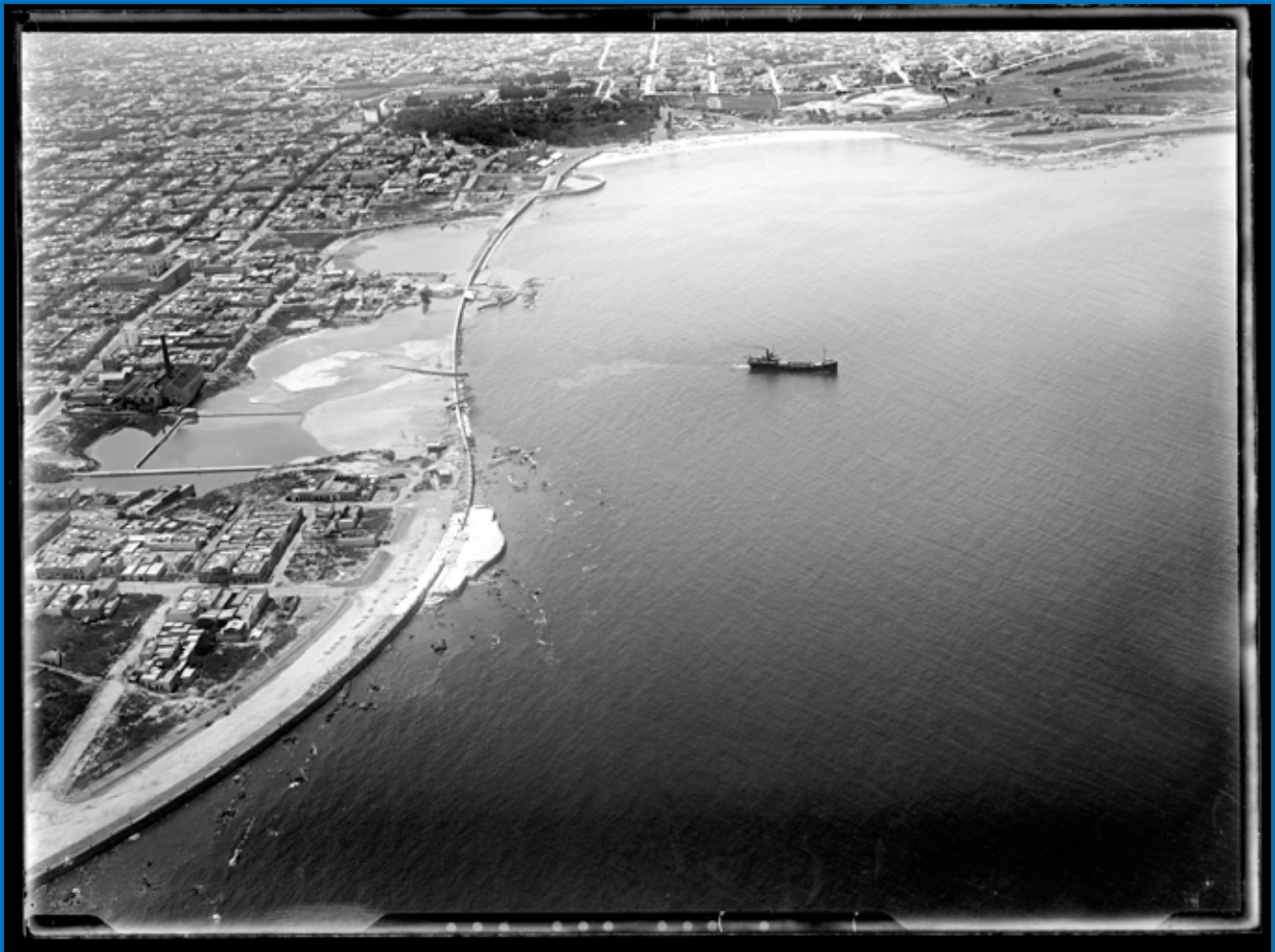
Vista aérea de las playas de Santa Ana y Patricio durante las obras de drenaje y relleno para la construcción de la rambla Sur, años 1926-1935. En 1986, la rambla en toda su extensión fue declarada Monumento Histórico Cultural. Foto: 0174FMHE.CDF.IMO.UY
