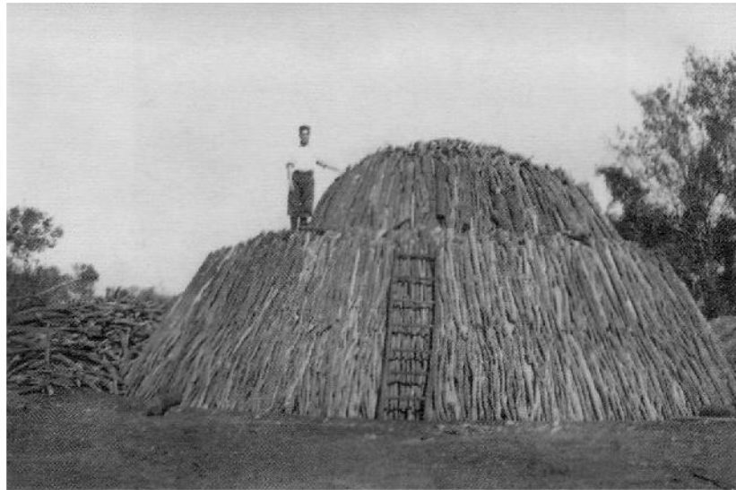
Armado de un horno para carbón (1939)
