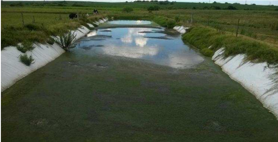
Figura 10. Pileta de almacenaje con cobertura de plástico de silos.
