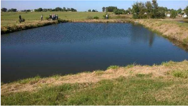
Figura 1. Tercera pileta de un sistema de múltiples piletas de tratamiento.
