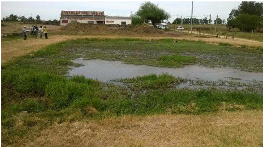
Figura 9. Ejemplo de una pileta de decantación colmada de sólidos, lo que afecta tanto el posible tratamiento como su capacidad de almacenaje.
