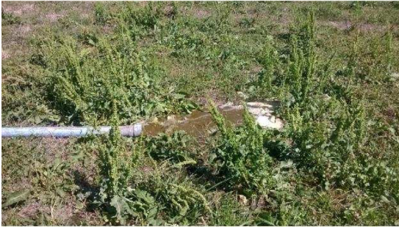
Figura 3. Vertido del efluente del tambo mediante un caño abierto
