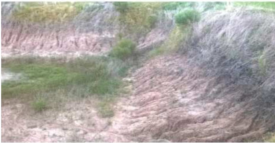
Figura 11. Pileta de almacenaje vacía con una lámina de arcilla natural.
