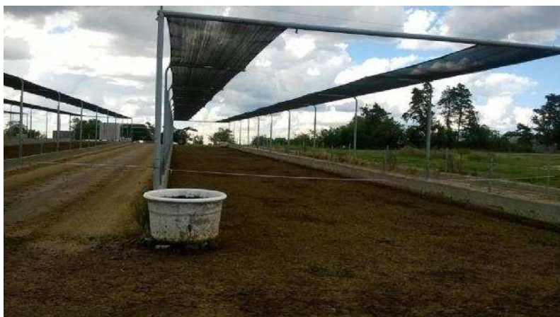
Figura 12. Un excelente ejemplo en el que en una playa de comida que tiene un sistema de separación de sólidos, se logra capturar la integridad de los efluentes.
