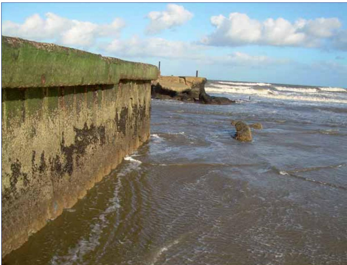
Modificaciones en el régimen hidrológico, asociadas a la construcción de estructuras rígidas, ya sea en la costa (e.g. escolleras, espigones) como en sistemas acuáticos continentales (i.e. represas y/o desecación de humedales por canalización), pueden intensificar los procesos erosivos de la franja costera como en la playa La Coronilla. *Foto: A. Carranza.*
