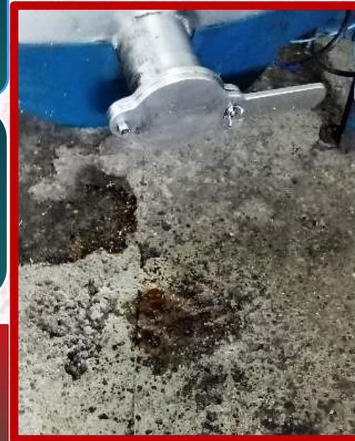
*Piso de hormigón sin lustrar, erosionado por efecto de la miel*
