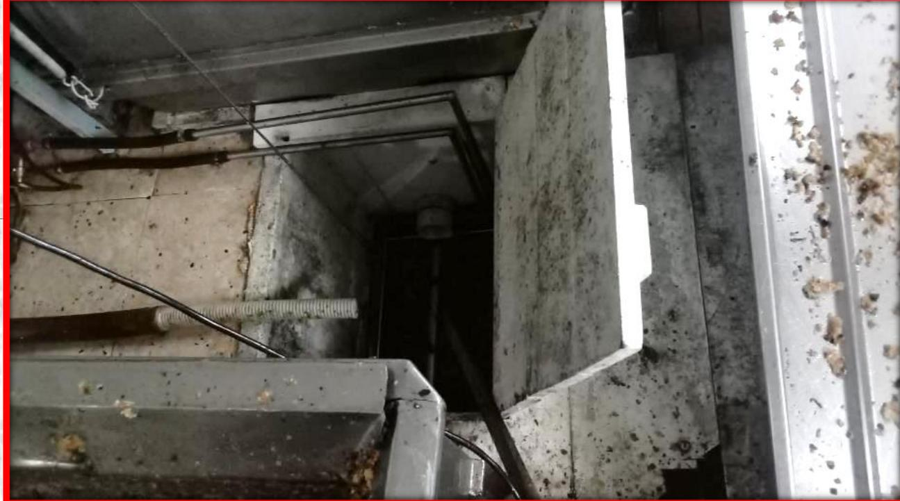
**FOSAS PROFUNDAS: MAYOR FRECUENCIA DE ACUMULACIÓN DE RESIDUOS, DIFÍCIL DE MANTENER, DIFÍCIL DE LIMPIAR, FUENTE DE DETERIORO DE MIEL.**
