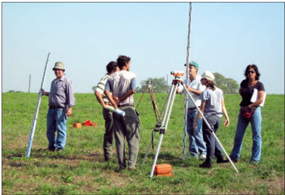
Foto 2. Marcación de la obra
