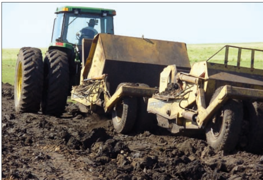
Foto 3. Construcción de terraplén
