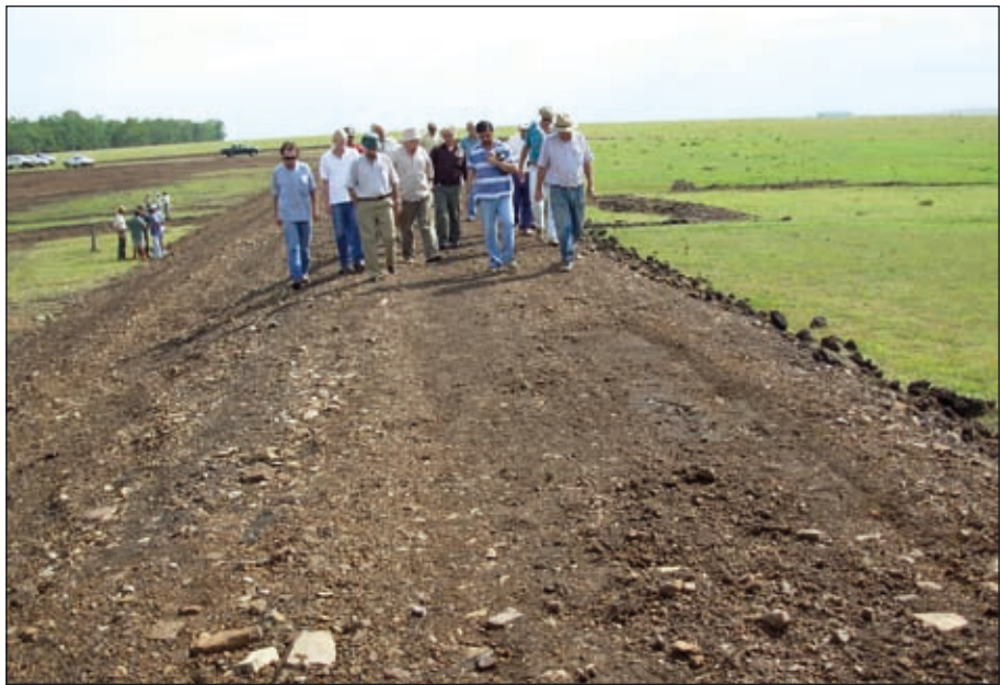
Foto 1. Inspección en Paraje Topador, Artigas
