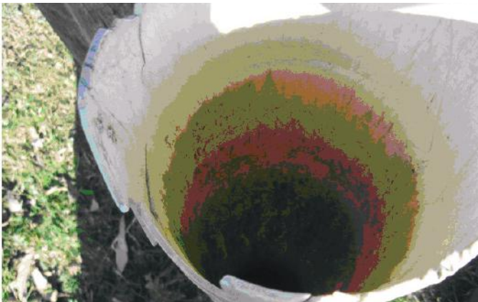
Fig. 23. Tubería sanitaria no apropiada para revestimiento de pozo
