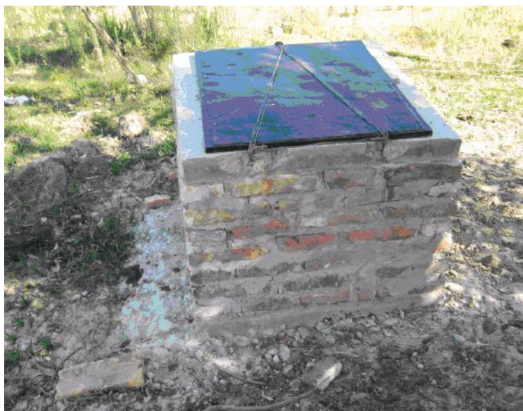
Fig. 29. Casilla de protección de pozo
