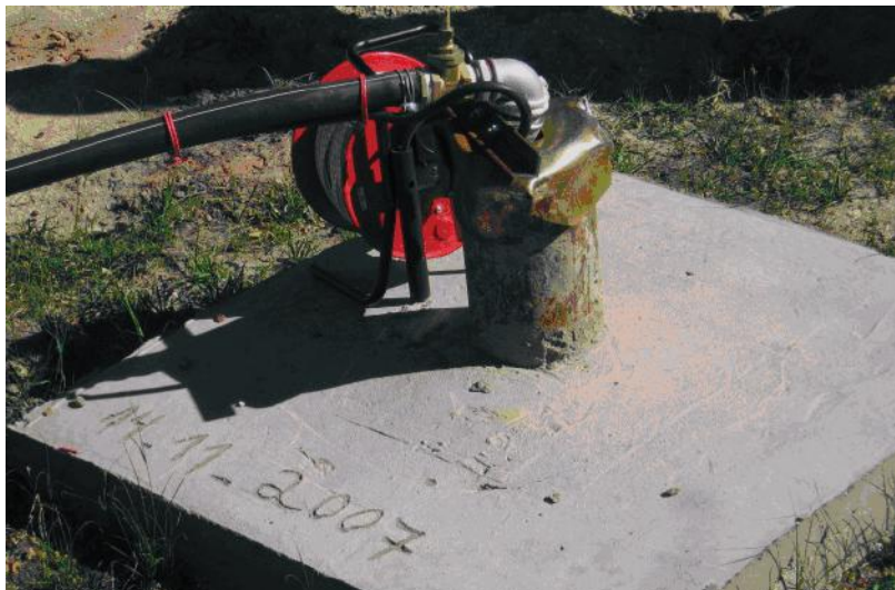
Fig. 28. Losa sanitaria. Terminación en superficie
