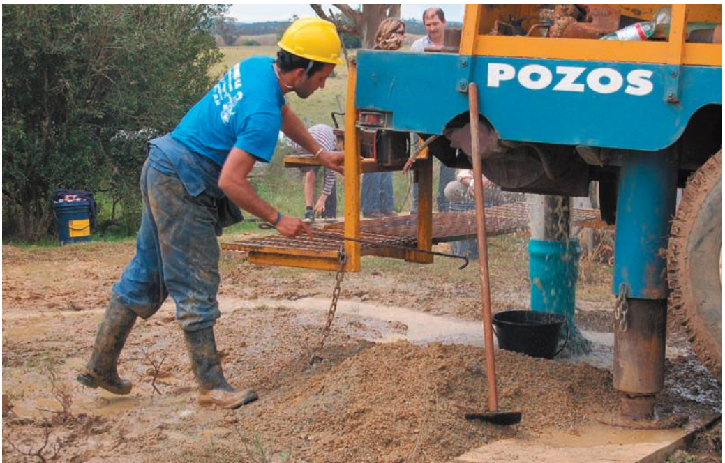
Fig.22. Perforador durante la construcción de un pozo.
