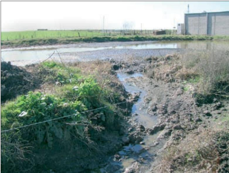
Taludes destrozados, el efluente corre sin control.
