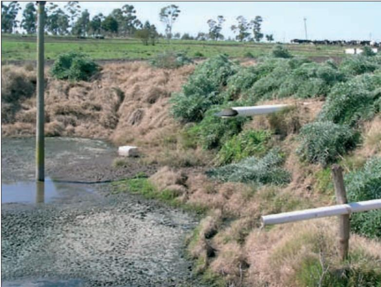
Laguna con taludes erosionados. Caños de entrada sin mantenimiento.
