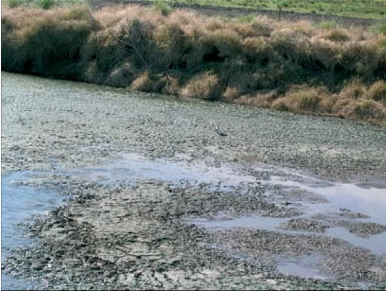
Lagunas con mal mantenimiento. Laguna colmatada y los taludes totalmente degradados.
