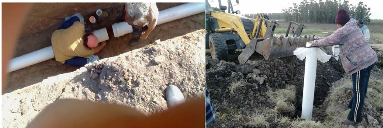
Trabajos de instalación de la cañería enterrada en el suelo, antes de la construcción del invernáculo, en el predio de Margaret Rocha. Junio de 2015.
