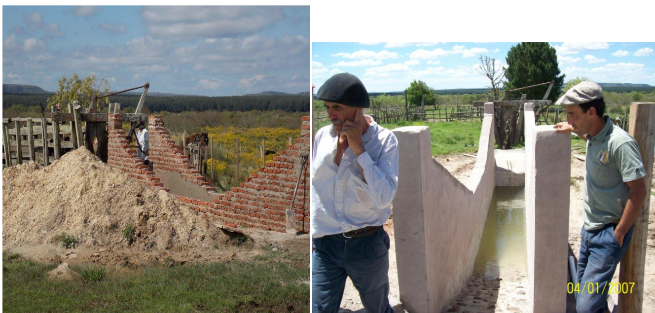
Construcción del baño de inmersión
