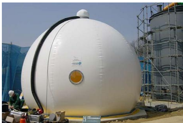
Ilustración 26 - Gasómetro de Doble Membrana – Fuente: Sattler-Ceno Biogas
