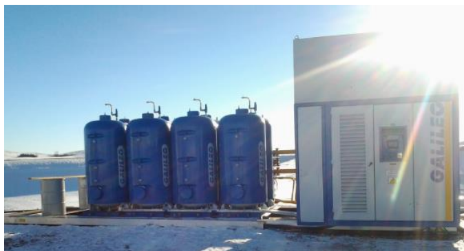
Ilustración 37 - Planta Satélite de Regasificación de Galileo Technologies S.A. (Fuente: TECNORed)
