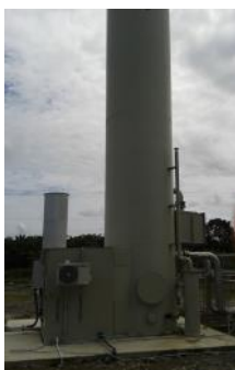
Ilustración 6: Unidad de desulfurización biológica interna TS-Umwelttechnik GmbH. Fuente: Foto Mitschke 2013
