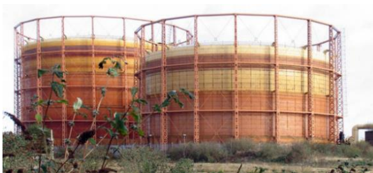
Ilustración 29 - Gasómetro Flotante con sello Hidráulico (Fuente: TECNORed)
