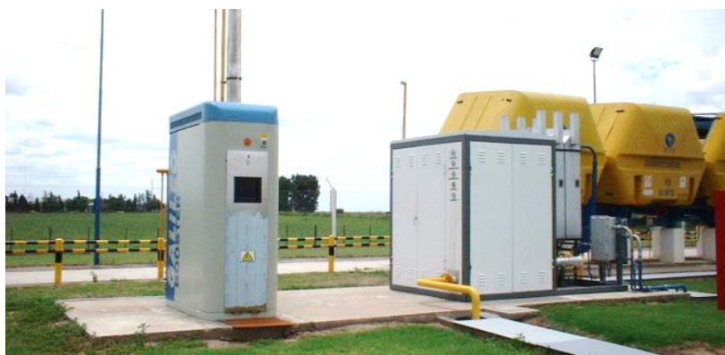
Ilustración 33 - Planta de Descarga y Regulación Modular de Galileo Technologies S.A. (Fuente: TECNORed)
