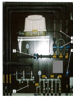
Ilustración 4: Unidad de desulfuración biológica interna con bomba de aire (Fuente: www.biogas.de )
