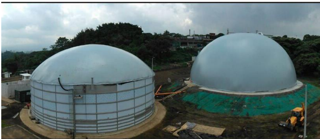
Ilustración 20: Almacenamientos de biogás con membranas internos y externos en la planta de referencia de AD Solutions en Costa Rica (Fuente: AD Solutions 2015)
