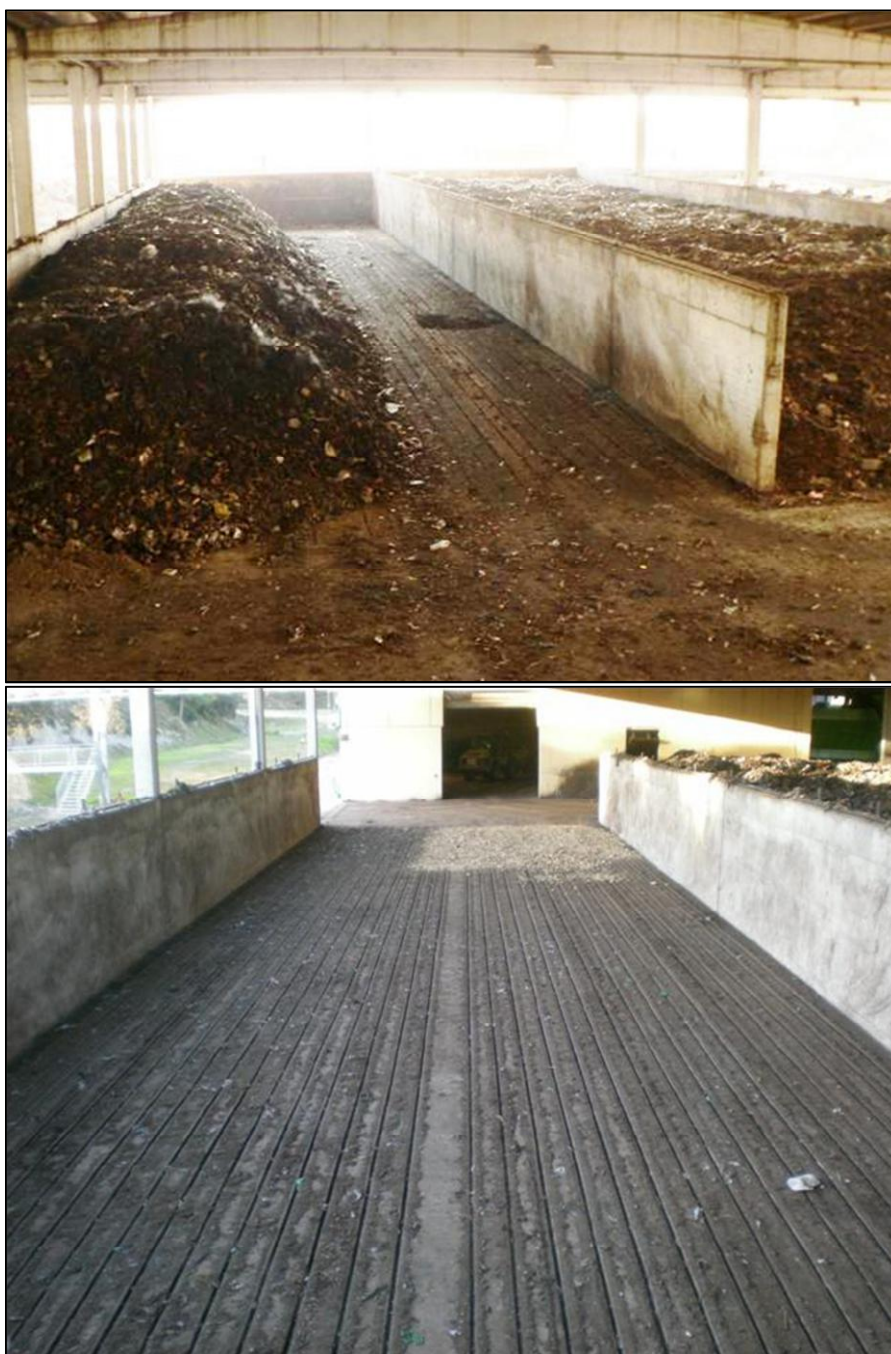
Figura nº. 18. Silo estático sin cubierta de lona y detalle de canalizaciones de aireación
