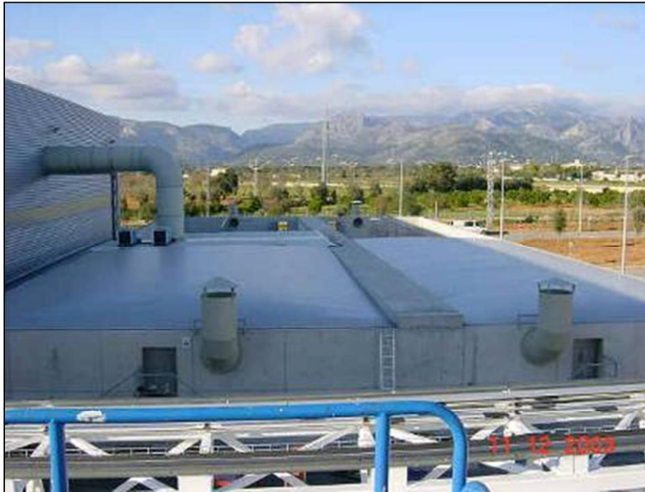
Figura nº. 4. Vista general biofiltros cerrados con relleno inorgánico en una planta de tratamiento de RSU
