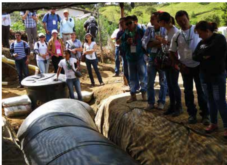
Ilustración 18. Biodigestor en geomembra para tratamiento de excretas de cerdo - Centro de Promoción de Energías Alternativas y Biomasa (TerraZoNet - Granja Porcicola Guarne - Municipio de Guarne -Antioquia-Colombia).
