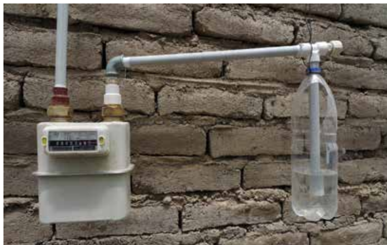
Ilustración 15. Flujómetro (Medición producción de biogas) y válvula de alivio de presión.
