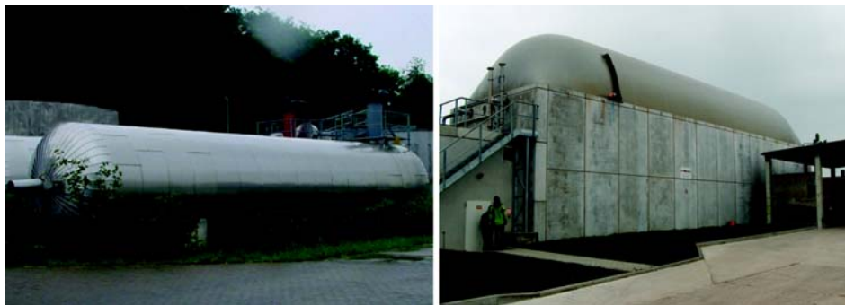
Figura 3.25: Reactores de flujo de pistón; ejemplos en campo, cilíndrico (izquierda), sección de caja, con reservorio de gas superior (derecha) [Novatech GmbH (izquierda), DBFZ (derecha)]
