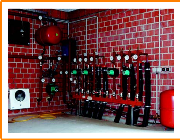
Figura 6.7: Distribuidor de calor [MT-Energie GmbH]
