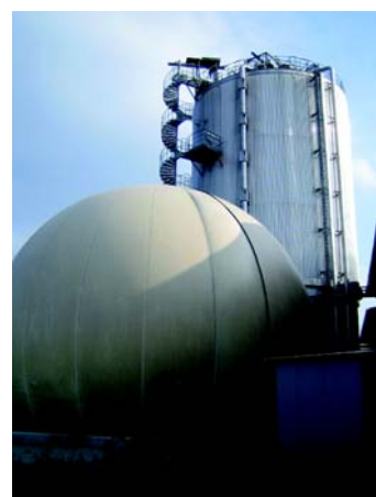
Figura 3.40: Ejemplo de un tanque de almacenamiento de láminas plásticas independientes con dos espesores de láminas plásticas [Schüsseler, FNR]
