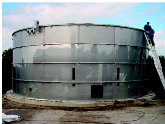
Figura 3.30: Un digestor de acero especial en construcción [Anlagen- und Apparatebau Lütke GmbH]
