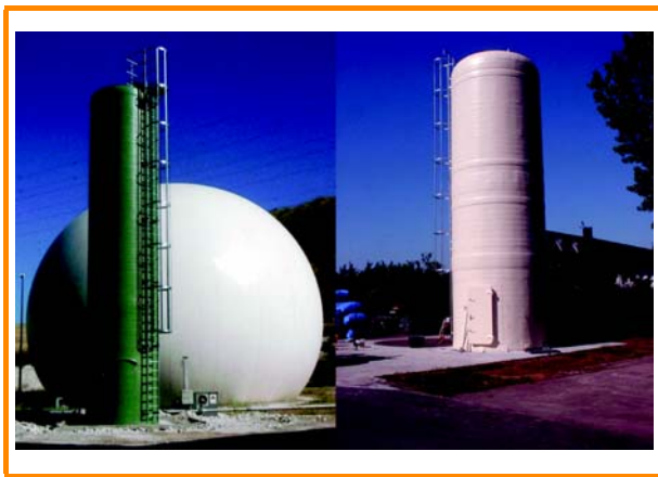
Figura 6.2: Torres externas de desulfuración biológica, a la derecha de un contenedor de gas [S&H GmbH & Co. Umweltengineering KG].
