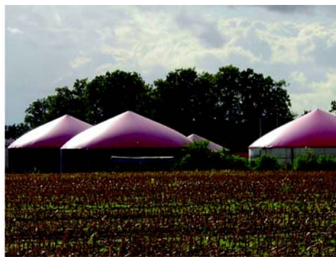
Figura 3.39: Estructura del soporte de un techo flotante (izquierda) planta de biogás con tanques de techos flotantes [MT-Energie GmbH]
