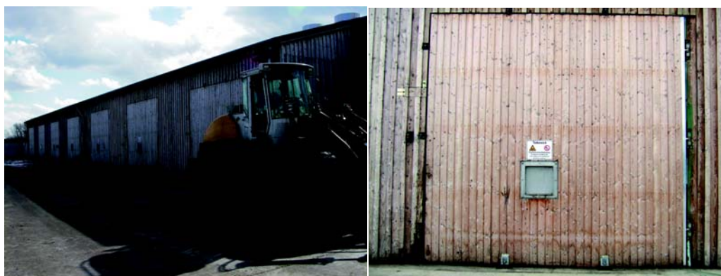
Figura 3.26: Ejemplo de digestores de caja; batería de digestores [Weiland, vTI] y puerta de digestor de caja [Paterson, FNR]
