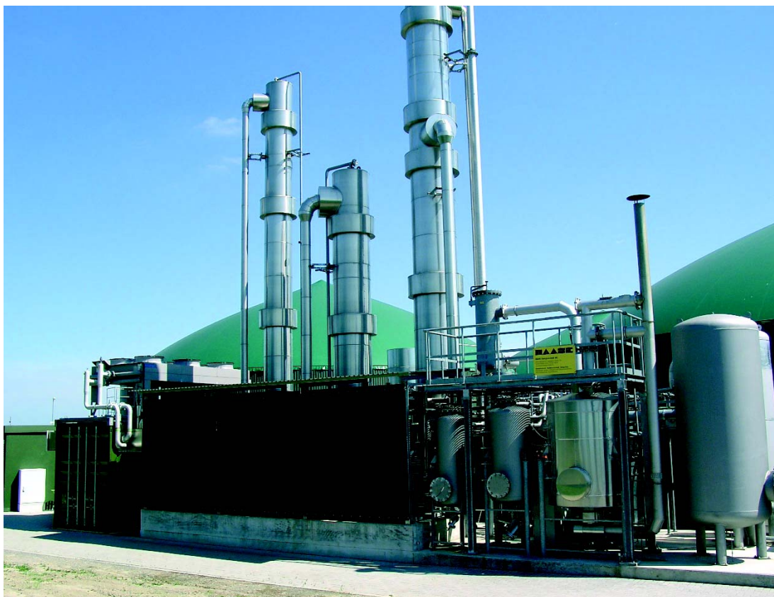
Figura 6.3: Planta de tratamiento de biogás (limpieza con Genosorb) en Ronnenberg [Urban, Fraunhofer UMSICHT]
