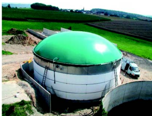
Figura 3.30: Un digestor de acero especial en construcción [Anlagen- und Apparatebau Lütke GmbH]
