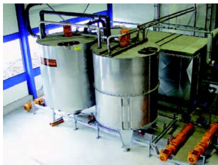
Figura 3.10: Higienización con re-enfriamiento [TEWE Elektronik GmbH & Co. KG]
