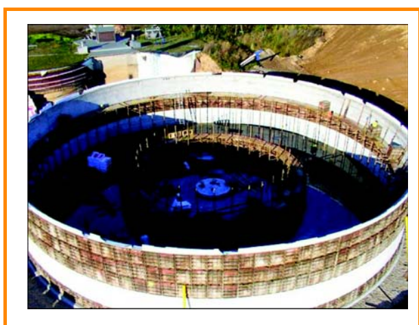
Figura 3.29: Un digestor de concreto en construcción [Johann Wolf GmbH & Co Systembau KG]
