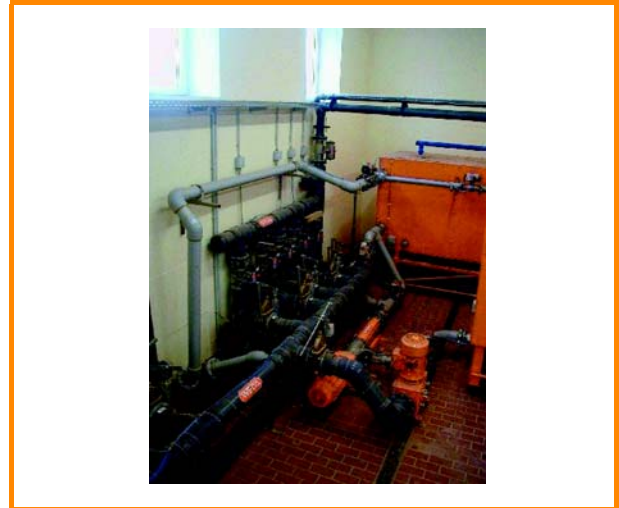
Figura 3.11: Bomba según la planta de biogás [WELtec BioPower GmbH]
