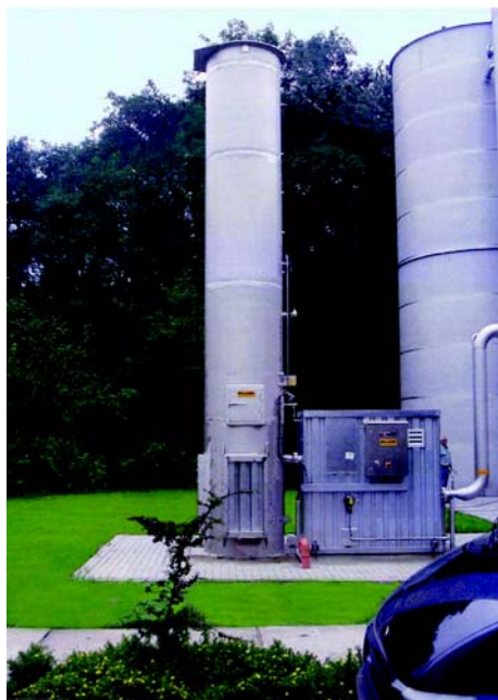
Figura 3.41: Bengala de almacenamiento de una planta de biogás [Haase Umwelttechnik AG]
