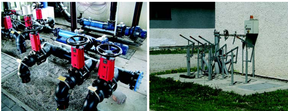
Figura 3.20: Tuberías, válvulas y accesorios de la estación de bombeo, y válvulas de cierre [DBFZ]
