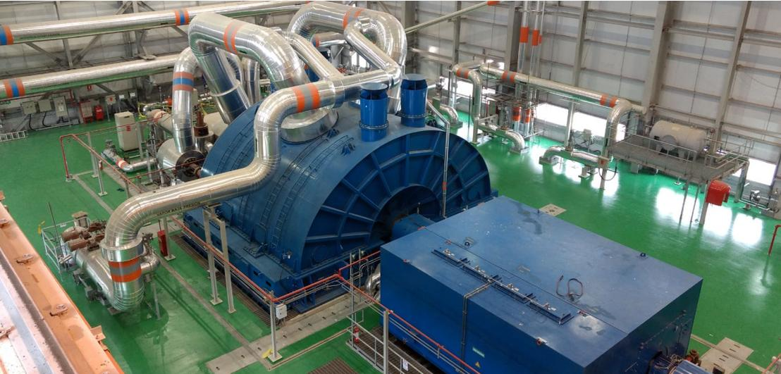
Se inaugura el Ciclo Combinado de la Central de Punta del Tigre B, que permite optimizar el gasto de combustible a través de dos turbinas que funcionan con gasoil o gas natural y una tercera que aprovecha el vapor generado por éstas, sin necesidad de combustible adicional. La inversión rondó los U\$S 500 millones.
