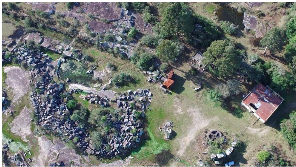
Fig. 3. Vista general de las antiguas explotaciones, además de los frentes se observan bloques, talleres, base de una grúa, tachos especiales de carga pesada e infraestructura ferroviaria.
