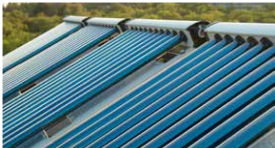
Figura 5. Colector solar para agua caliente
