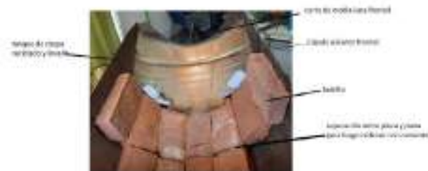
La bóveda de ladrillo o de gres y sus partes principales:
