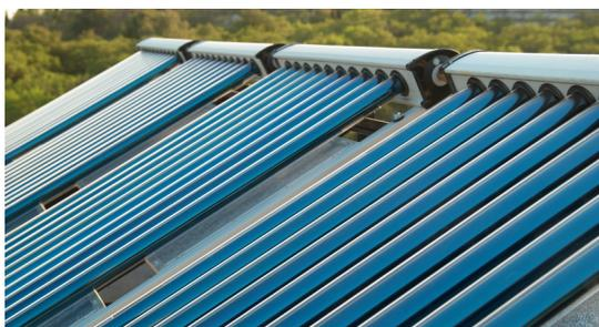
Figura 5. Colector solar para agua caliente
