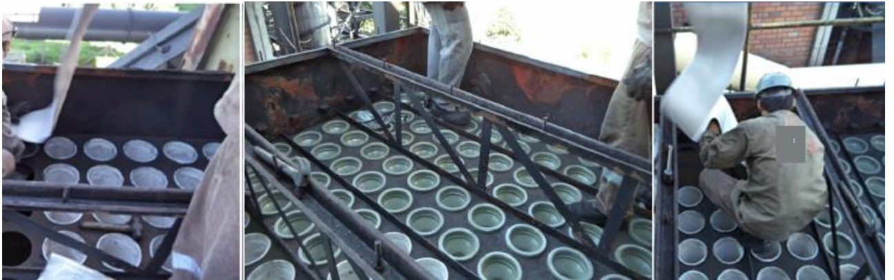
Imagen 03 – Mantenimiento de filtros de manga.
