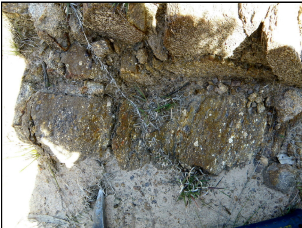
Foto 46: Detalle de areniscas gravilosas.
