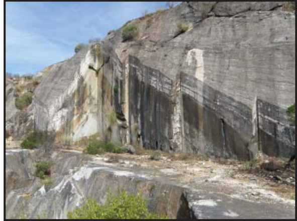
Foto 77: Vista general del frente de cantera, corte con hilo diamantado.
