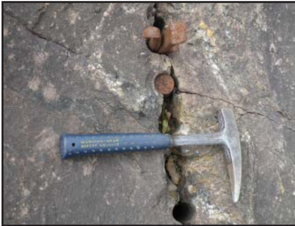
Foto 60: Detalle donde se observa sistema de corte y arranque del bloque.
