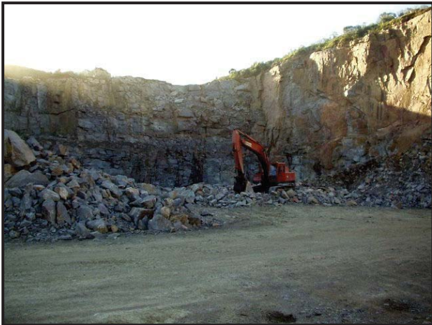
Foto 22: Carga con retro de piedra "volada"
