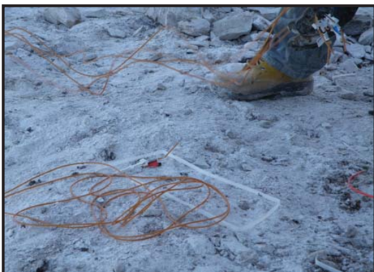
Foto116: Carga de explosivos para voladura.
