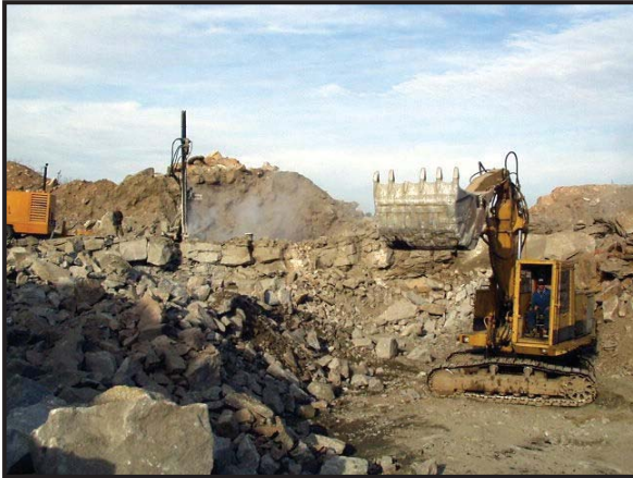
Foto 19: Línea de barrenos para voladura.
