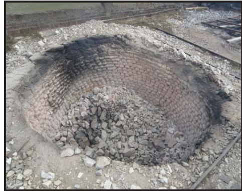
Foto 172: Boca de horno vertical.
