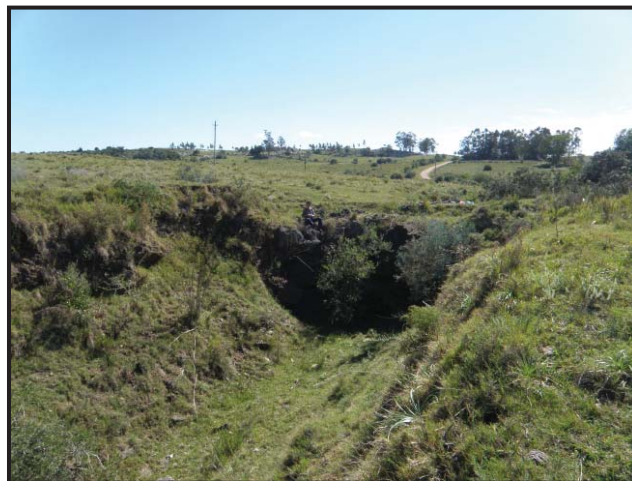
Foto 105: Vista general de socavón.
