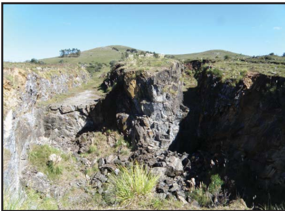
Foto 98: Vista general de la cantera
