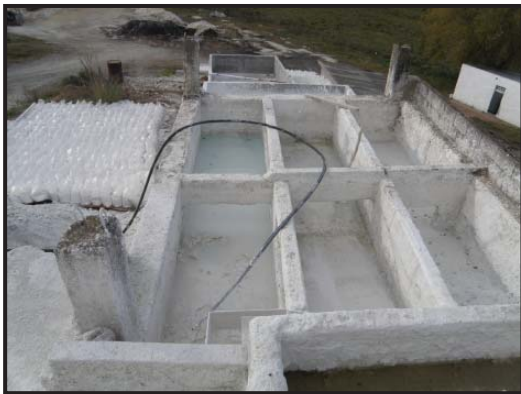
Foto 175: Piletas para producción de cal hidratada
