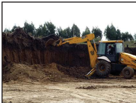
Foto 1: Extracción con retroexcavadora.
