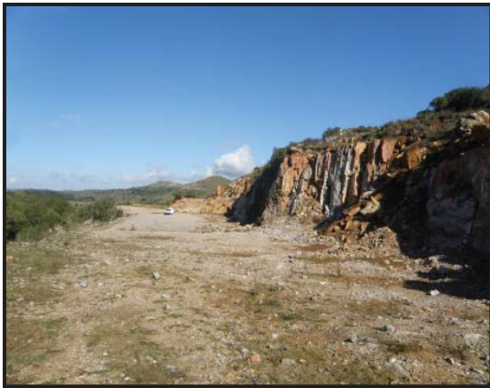
Foto 111: Vista general de cantera.
