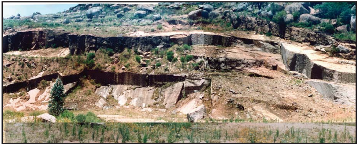
Foto 48: Vista panorámica del frente de cantera de Ficha G29-02.
