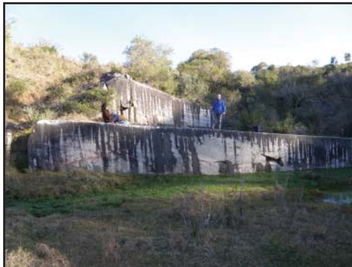
Foto 79: Vista general del frente de cantera
