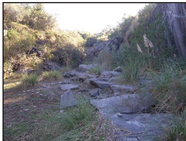
Foto 106: Vista del socavón al Oeste.
