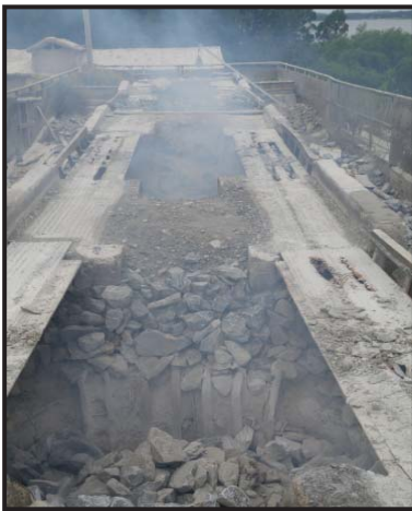
Foto 178: Bocas de horno.
