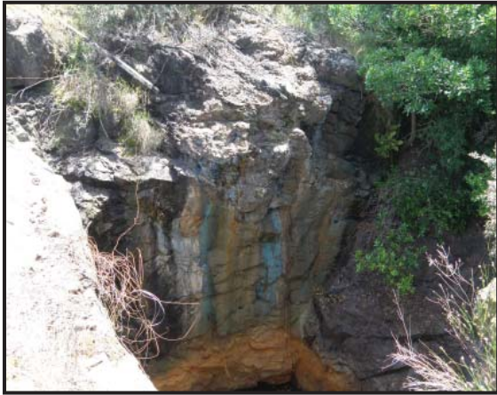
Foto 138: Boca de galería inundada.
