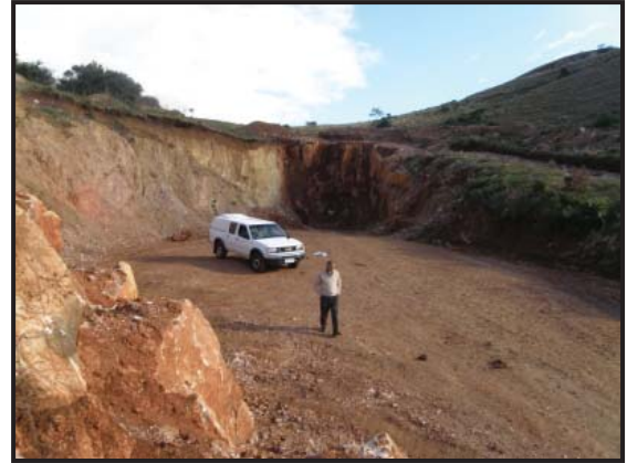
Foto 110: Vista general de cantera
