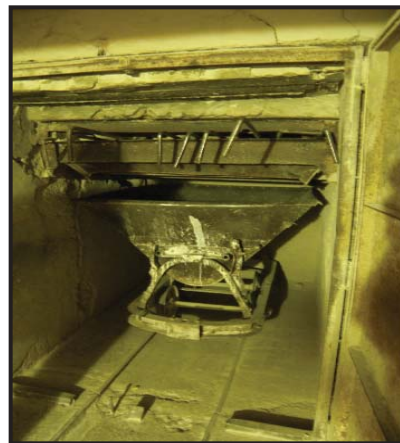
Foto 181: Zona de descarga de cal viva y vagonetas de carga.
