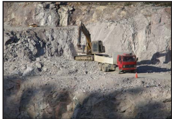
Foto 115: Arranque, carga y transporte.
