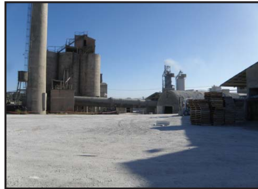
Foto 170: Vista general, planta de cemento.
