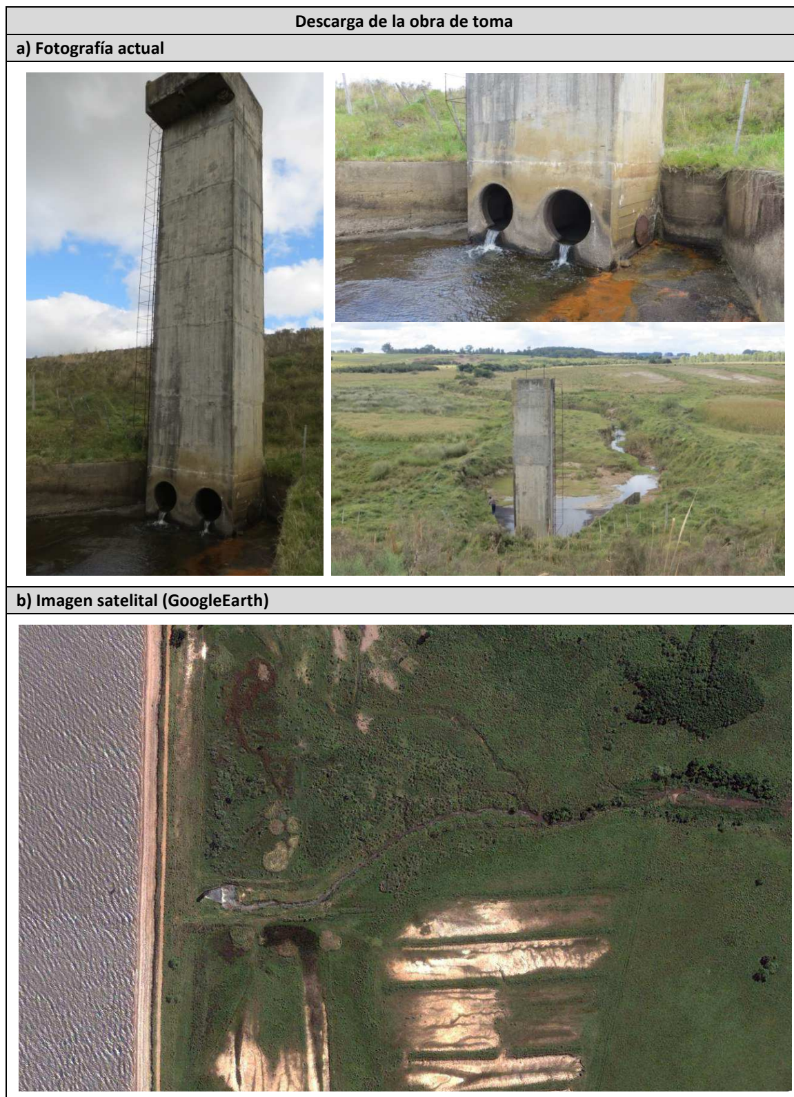
Figura 3-4: Descarga de la obra de toma.
