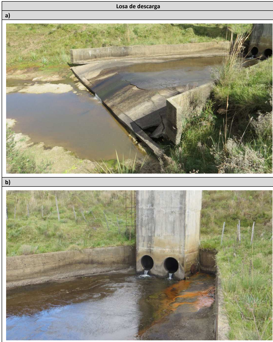
Figura 8-2: Losa de descarga existente.
