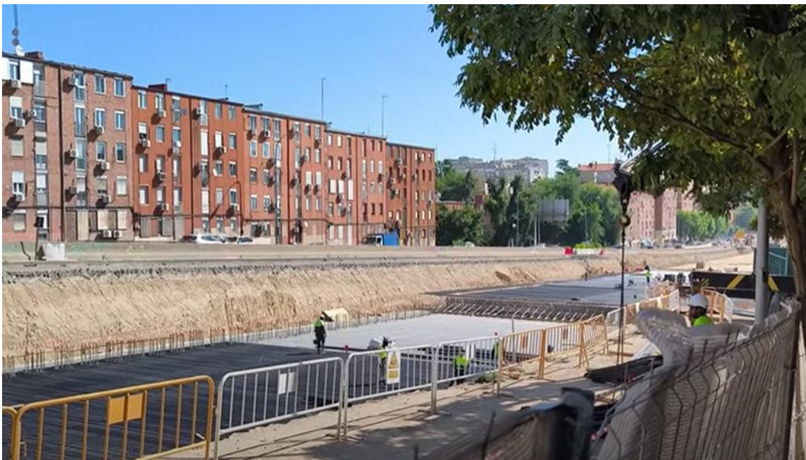
Figura 4-19. Vista ejecución de losa superior Cut&Cover. Soterramiento Autovía A5 - Madrid. Año 2025
