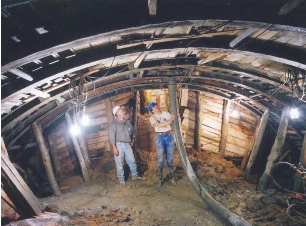
Figura 4-3. Encofrado y hormigonado de la bóveda
