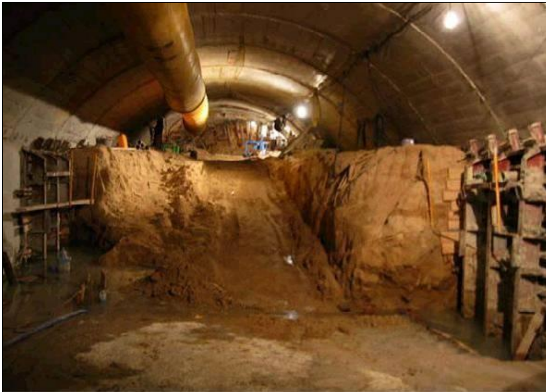
Figura 4-4. Destroza y ejecución de hastiales desfasados
