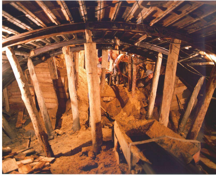
Figura 6-2 Sostenimiento provisional en bóveda y apuntalamiento de longarinas según el Método Belga.
