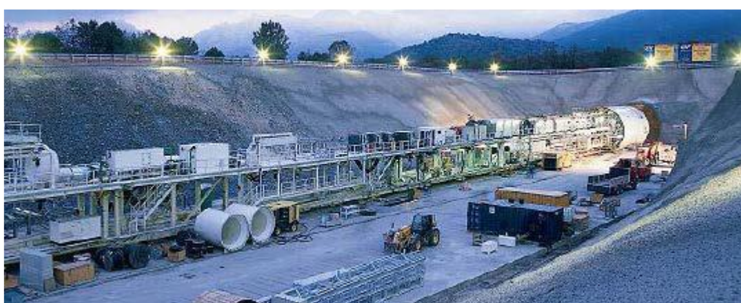
Figura 4-17. Ejemplo Back-up de tuneladora (II)
