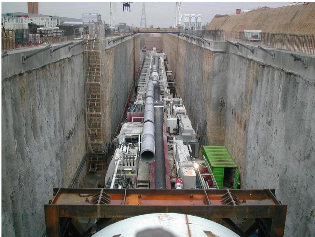
Figura 4-16. Ejemplo Back-up de tuneladora (I)
