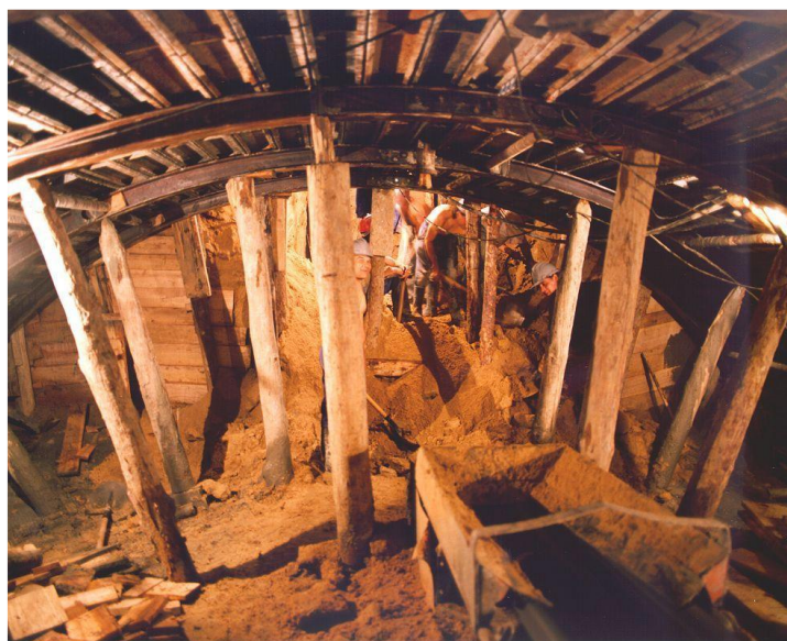
Figura 4-1. Sostenimiento provisional en bóveda y apuntalamiento de longarinas según el Método Belga
