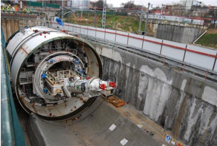
Figura 4-13. Escudo y tornillo sinfín de tuneladora EPB túnel Atocha – Chamartín (Madrid)
