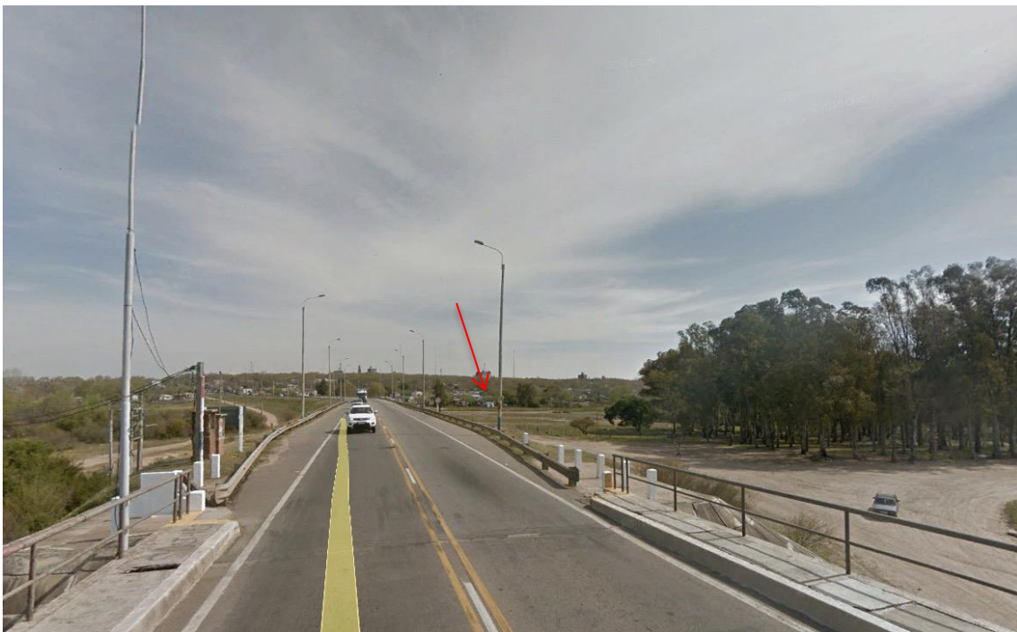
Gráfico 5-4: Vista hacia el Suroeste desde la cabecera sur del puente de la Ruta 5 sobre el Río Yi (foto Street View de Google Earth®, setiembre 2015). La flecha roja indica la residencia habitacional más cercana.
