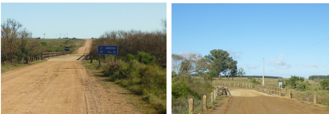
Gráfico 5-5: Puente sobre el Arroyo Arrayán (izquierda); puente sobre el Arroyo Sauce de Mansavillagra (derecha)
