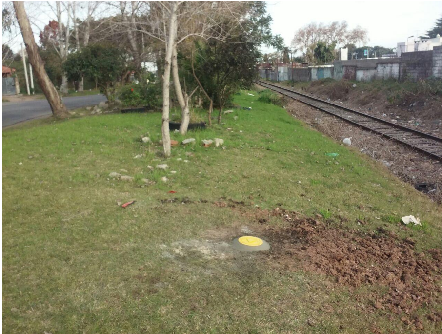
ILUSTRACIÓN 12. FREATÍMETRO TR217 FINALIZADO
